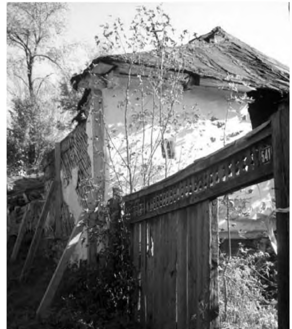
"Reabilitare" RMGC. Clădire din zona "conservată" cu zeci de milioane de euro (Foto: Luminița Dejeu)
