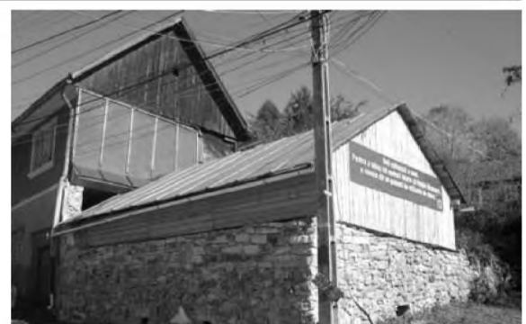
"Salvare" tipică pentru RMGC. Din cea mai veche casă atestată istoric din Roșia Montană a mai rămas doar fundația și un șopru pe care e amplasată plăcuța cu mențiunea "Monument istoric" (Foto: Luminița Dejeu)
