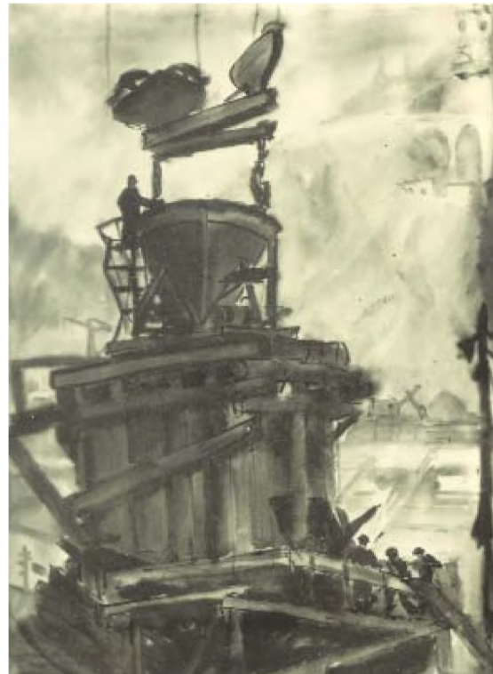
HĂLĂUCESCU Iulia - Turnarea betonului la barajul Hidrocentralei Bicz, Muzeul Național de Artă Contemporană București
