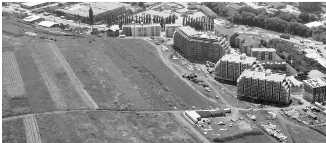
Blocuri în construcție, Baciu
