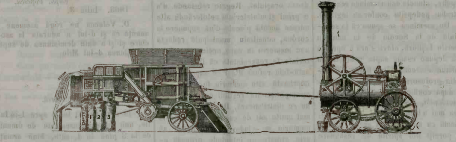
Masina de treerat cu locomobila cu putere de 8 cai
