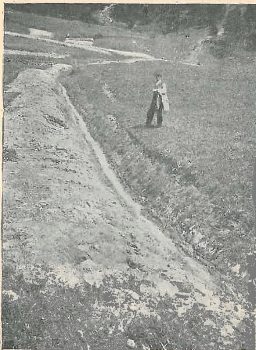
Tip de dren pavat în formă de V.
