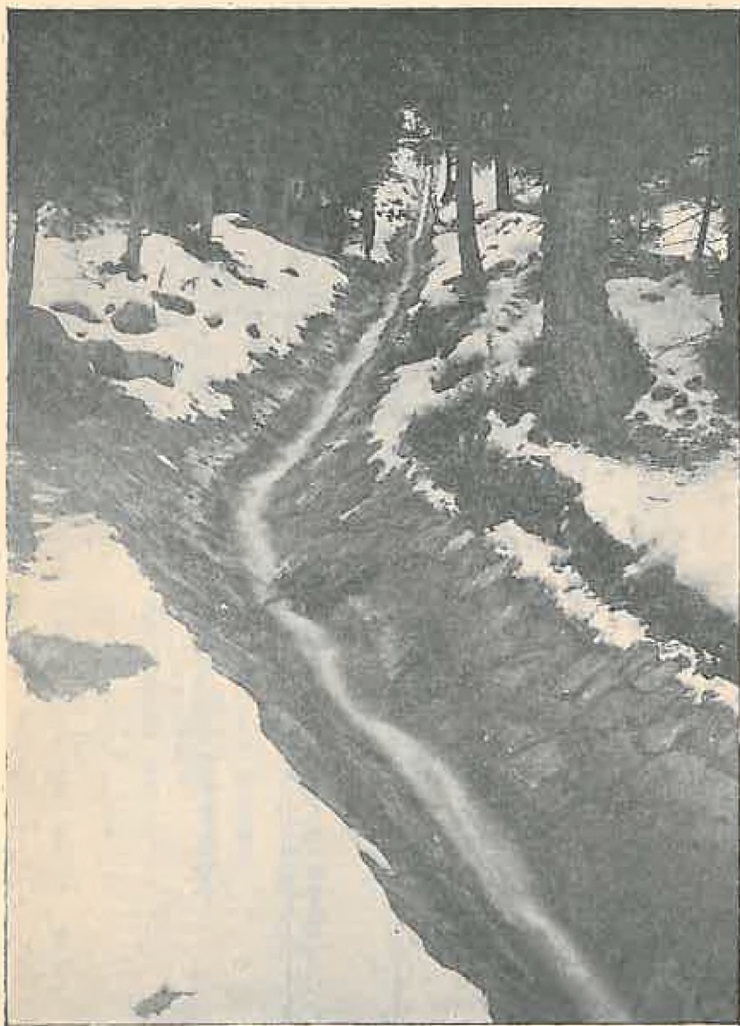
Tip de dren descoperit. Pietrele dela coronament au cea mai mare dimensiune perpendiculară și nu paralelă la ax.
