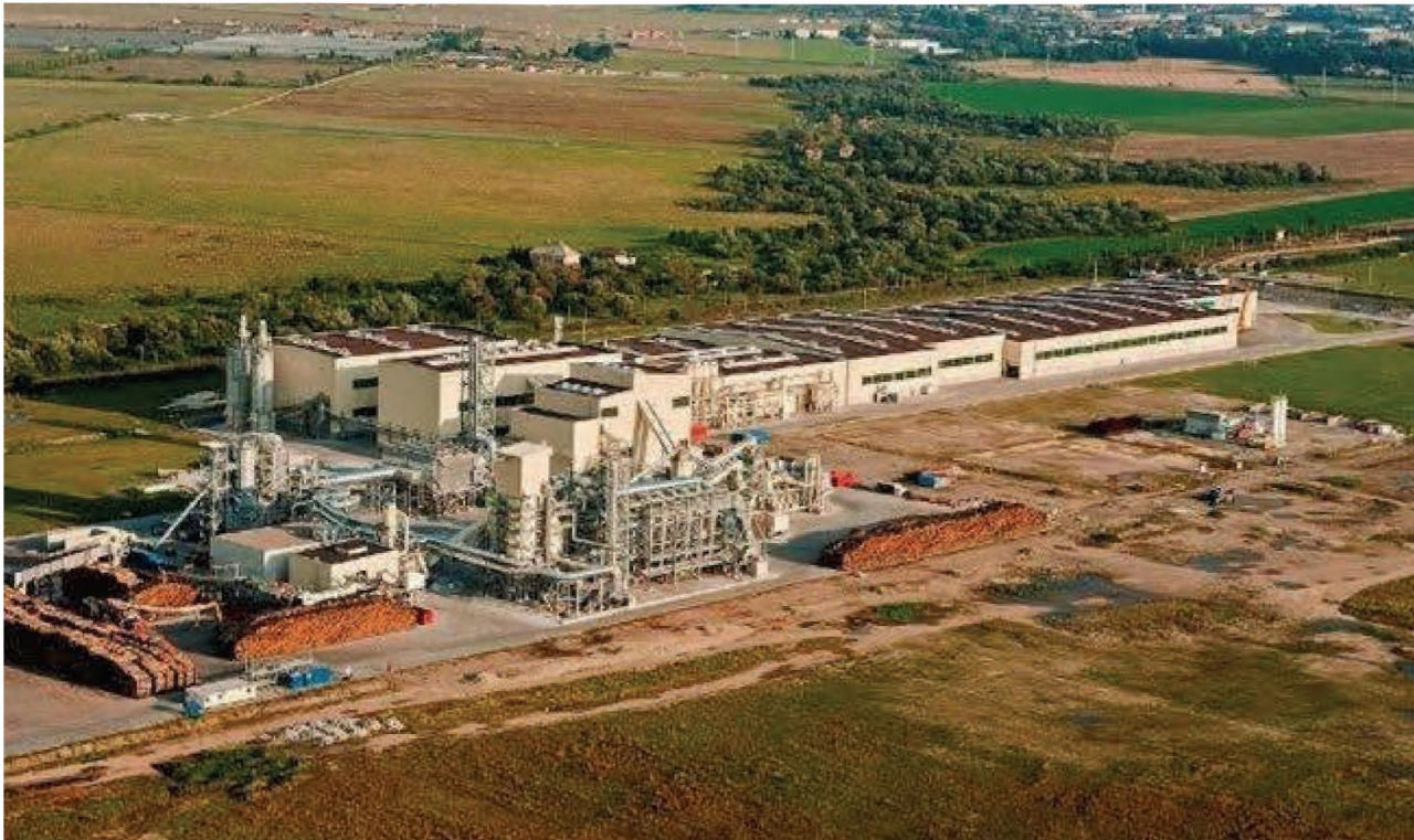
Figura 1. Fabrica Kronospan Trading Brașov. Sursa: [11].
