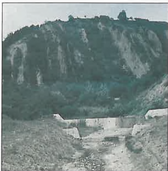
Foto 4. Vegetație forestieră instalată natural, la adăpostul creat de lucrările hidrotehnice de corectare a torenților. Foto: Munteanu, 1965.
