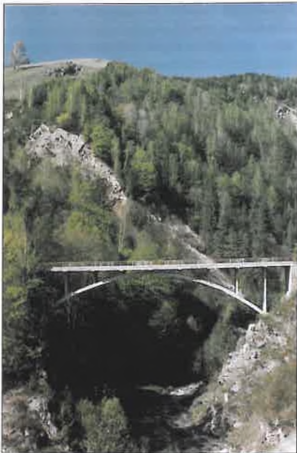
Foto 3. Viaductul Bistra, construit în fondul forestier (după R. Bereziuc și V. Popovici, 2006).
