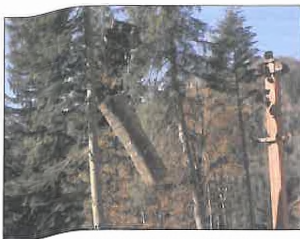
Fig. 6. Instalație cu pilon Syncrofalke în lucru
