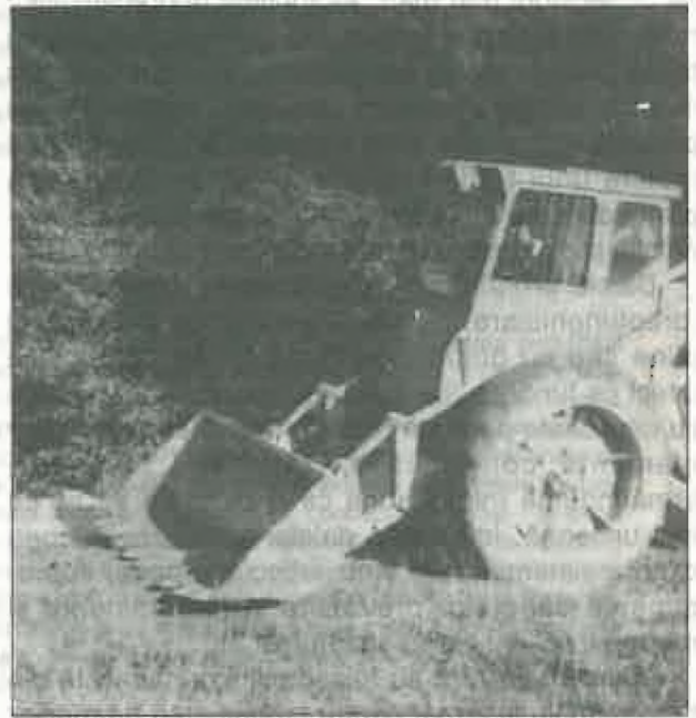
Foto 1. Răspîndirea balastului cu cupa IFRON. (Spreading of the ballast with the bucket IFRON).
