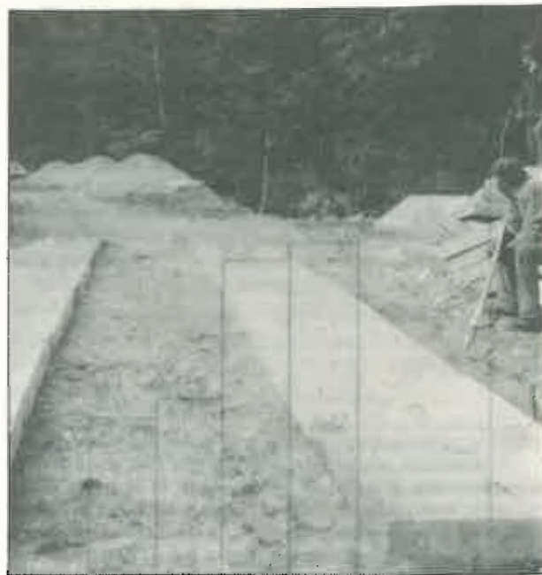
Foto 3. Dale așezate pe cele două șiruri. (Slabs placed on two rows).
