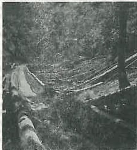
Fig. 1. Canal de apă pentru scosul lemnului (tehnologie învechită).
