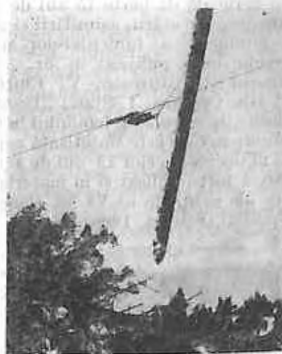
Fig. 3. Funicularul FPU-500 pentru colectarea lemnului pe distanțe mijlocii.
