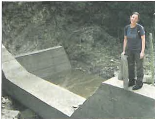
Foto 1. Lucrări de corectare a torenților la O.S. Târgu Ocna (D.S. Bacău)
