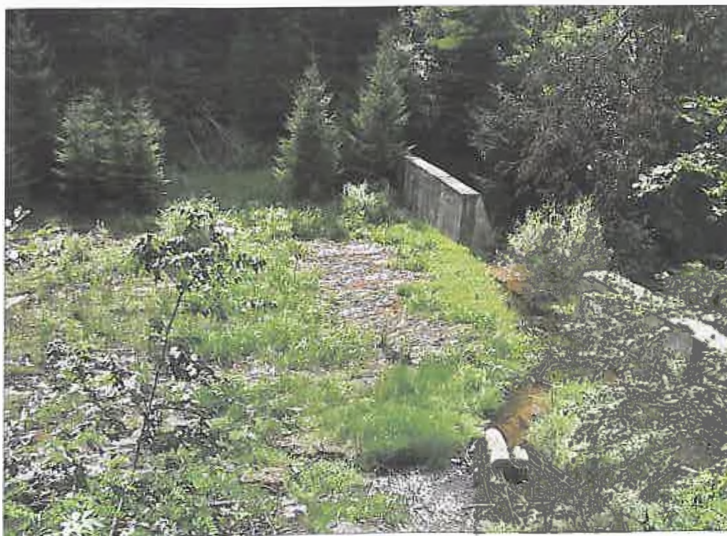
Fig. 2. Pârâul Păltința: consolidare prin aterisare la barajul 10P4.0) (Foto Florin Lupașcu, 2006)
