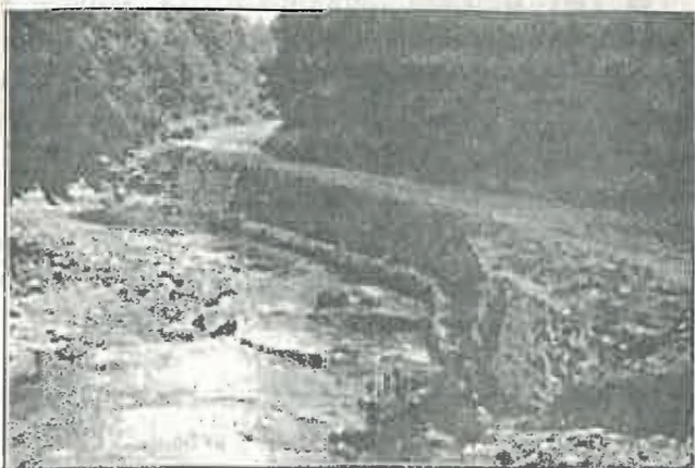
Fig. 2. Zid reparat. Drum forestier Olănești-Mînză. (Repaired wall. Forest road Olănești-Mînză).
