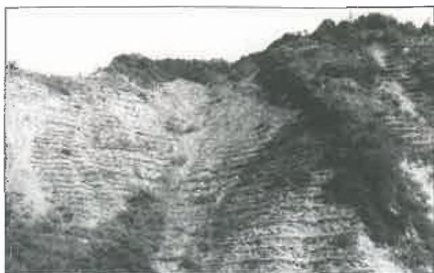
Foto 2. Terasse armate vegetal în perimetrul experimental Bârsești – Vrancea (foto E. Untaru, 1980)
