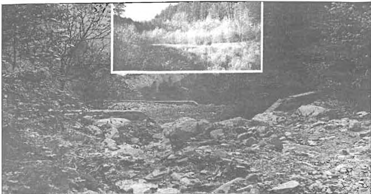
Fig.4. Scurgerea aluviunilor de pe versanți și din rețeaua hidrografică (cu precădere scurgerea aluviunilor grosiere) poate fi monitorizată cu ajutorul lucrărilor hidrotehnice transversale. Cum la adăpostul acestor lucrări se instalează vegetația forestieră, monitorizarea poate îmbrățișa și aspectul conjugării dintre lucrările hidrotehnice și cele de vegetație, aspect care este de o deosebită importanță practică (Clișeu: I. Clinclu)
