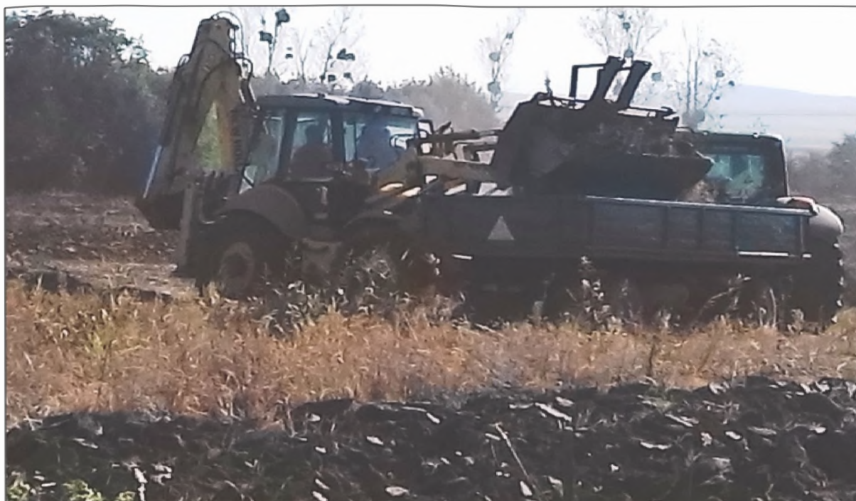
Fig. 5: Executarea lucrărilor de îndepărtare a vegetației și scoaterea cioatelor. Foto: M. Budeanu (2017)
