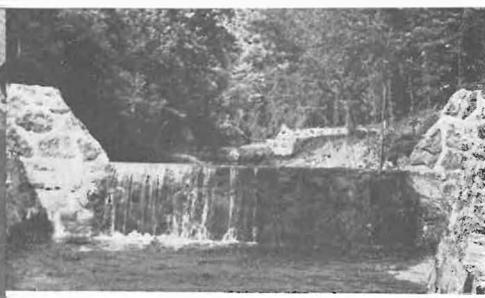
Fig. 1. Barajele de zidărie cu mortar, susținute de vegetația forestieră, contribuie la regularizarea cursurilor torențiale.
