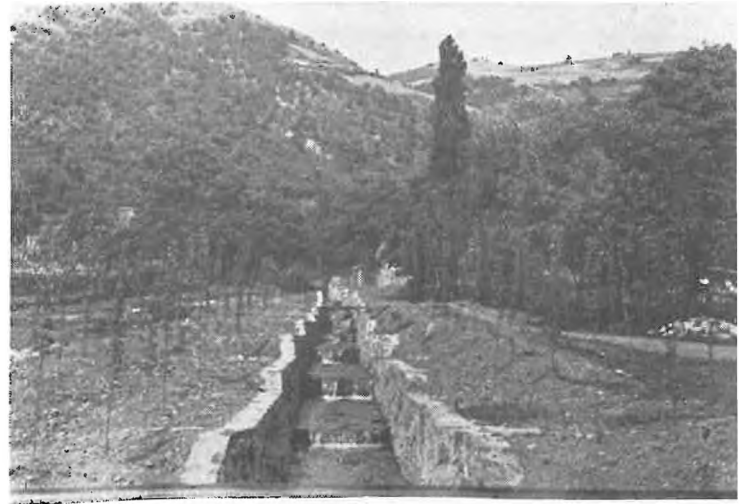
Fig. 2. Prin construirea de canale de zidărie cu mortar pavate în trepte și susținute lateral prin culturi forestiere se readuc în circuitul economic importante suprafețe de teren.
