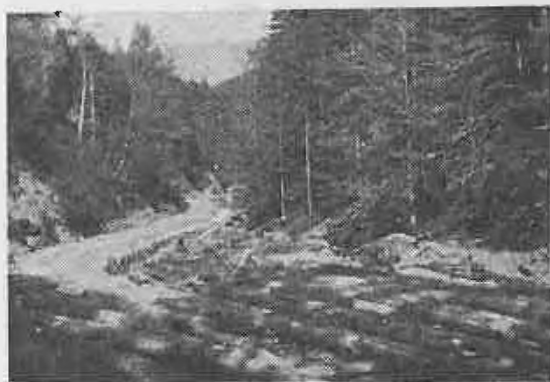
Fig. 5. Drum auto pe Valea Tigăii, la care s-au utilizat cășițe prefabricate la consolidarea taluzelor.
