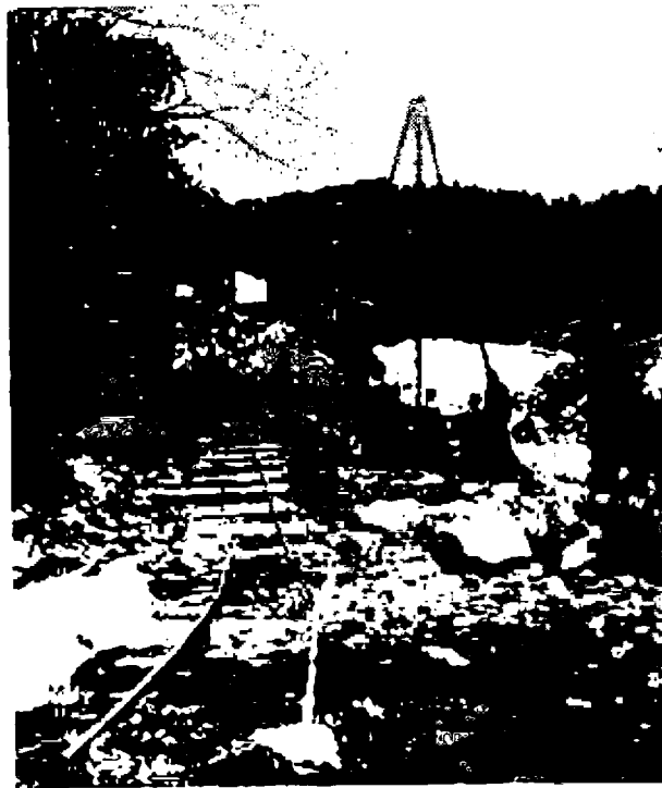
Fig. 3. Plan înclinat pentru transportul materialelor la executarea unui baraj pe torentul Călugăreni—Valea Bistriței.
