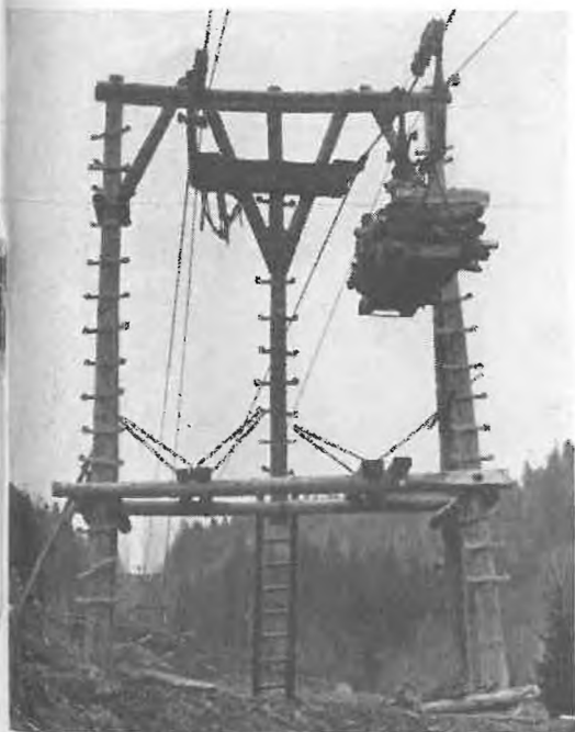
Fig. 2. În condiții grele de teren, materialul lemnos se scoate cu ajutorul juniculelor de tip ușor.
