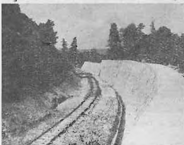
Fig. 4. Zidul de sprijin de la șoseaua Bărbălătești, pe linia c.f.f. Curtea de Argeș—Bahna, I.F.E.T. Curtea de Argeș, D. S. Pitești.
