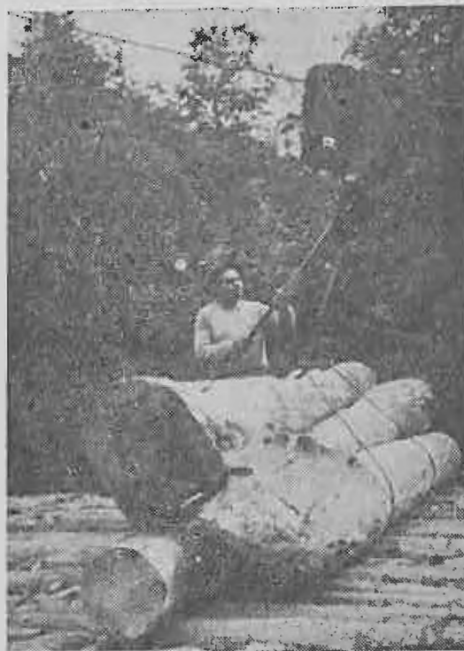
Fig. 2. Funicular tip Wyssen instalat în parchetul „Nagomirul” din I.F.E.T.-Stîlpeni pentru scoaterea fagului în trunchiuri.
