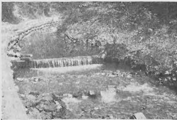
Fig. 3. Cascadă artificială podită pe pârâul Lîmbășel (Ocolul silvic Azuga). Foto V. Cotta.
