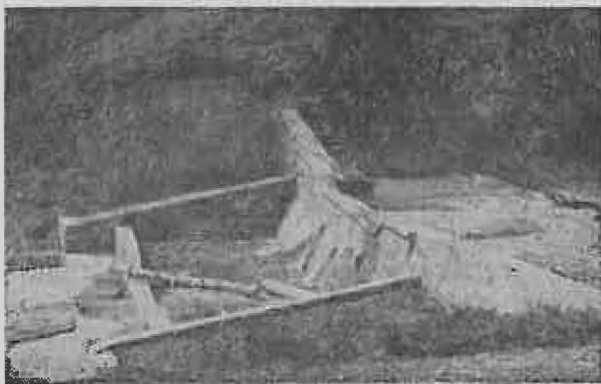
Fig. 6. Baraj cu deversorul blocat, construit în perimetrul Hangu Audia, pîrtul Adînc.
