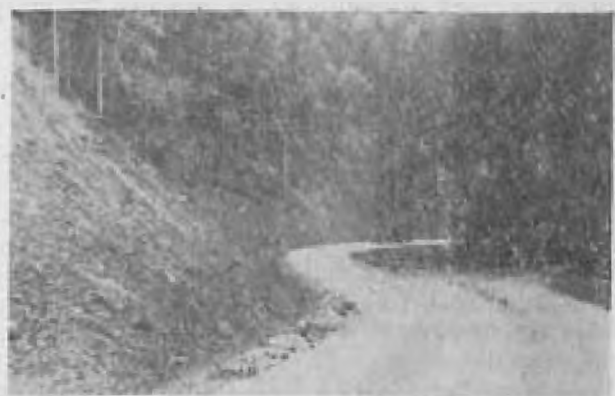
Fig. 2. Drumul auto-Korimovo. Porțiune în curs de finisare; se observă calitatea foarte bună a imbrăcămintei, ca urmare a execuției îngrijite.
