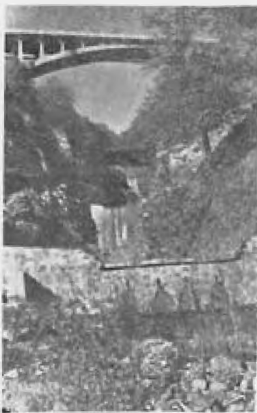
Fig. 4. Baraje executate în perimetrul Valea Orașilor, pe Valea Prahovei, D. S. Ploești.
