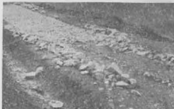
Fig. 1. Construcția suprastructurii drumului Korimovo. Se observă piatra de dimensiuni mari care se așază pe marginile fundației.
