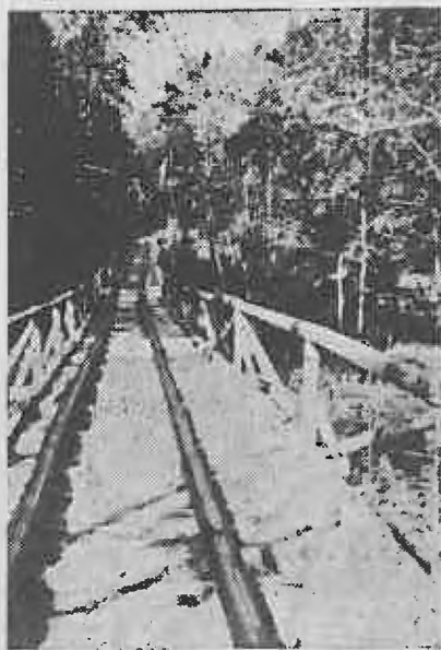
Fig. 1. Instalația de goange de la Bălătău (Corbu), I.F.E.T. Moinești. Rampa mare.
