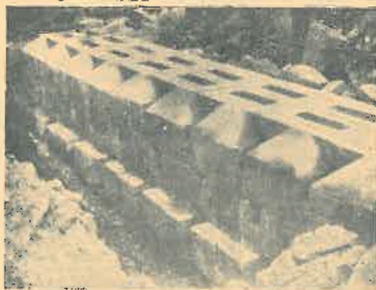
5. Barajul dren, sistem Rosici, detaliu al drenului
