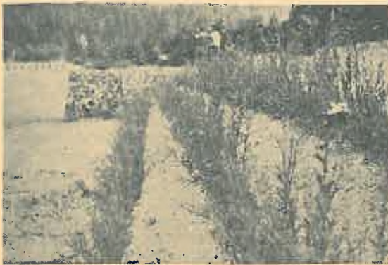
Foto. 6. — Fixarea versanților cu ajutorul sadelor de salcie butășite după metoda austriacă „Buschlagenverbaum“, torrentul Smeč. — doc. FAO —
