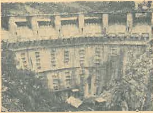
1. Marele baraj al hidrocentralei Jablanica foto ing. Tr. Mecotă
