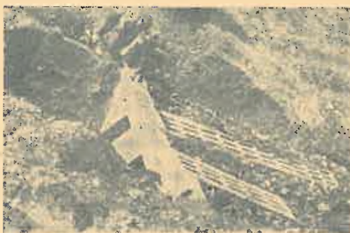
4. Barajul dren, sistem Rosici, vedere de ansamblu — torentul Zapotoki Potok — R. P. Serbia
