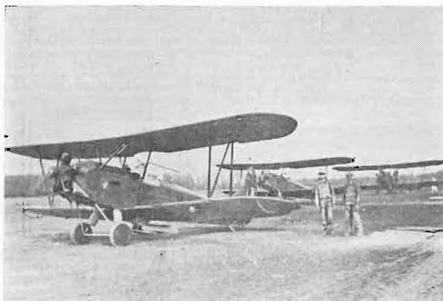
Fig. 1 -- Bază aviochimică în timpul lucrărilor
