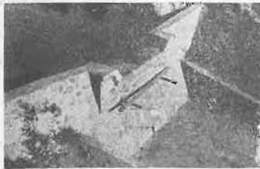
Fig. 14. Profil pentagonal proiectat după îndrumările autorilor și construit în anul 1952 pe un șantier din țară. (Foto St. Munteanu).
