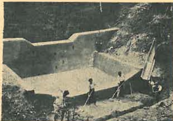
Fig. 2. Lucrări de stingere a torenților executate de Ministerul Silviculturii, Industriei Lemnului și Hârtiei în bazinul de interes hidroelectric al Argeșului — Comuna Băiculești. Construcția unui baraj de beton, cu radier și contrabaraj.
