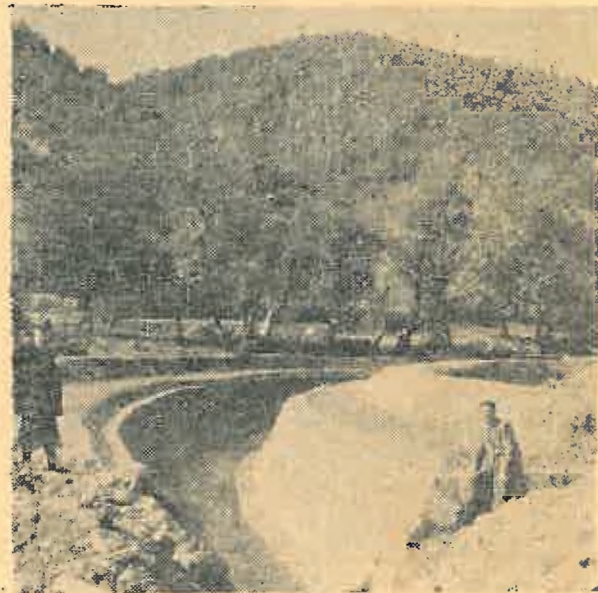
Fig. 7. După ce versanții au fost împăduși și aluviunile au fost reținute în spatele lucrării de retenție, apele limpezi sunt conduse prin canale fără a mai putea pricinui pagube.
