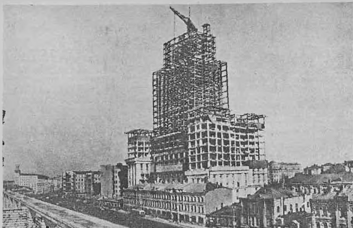
Macarale automate pe șantierul unei mari construcții din Moscova
