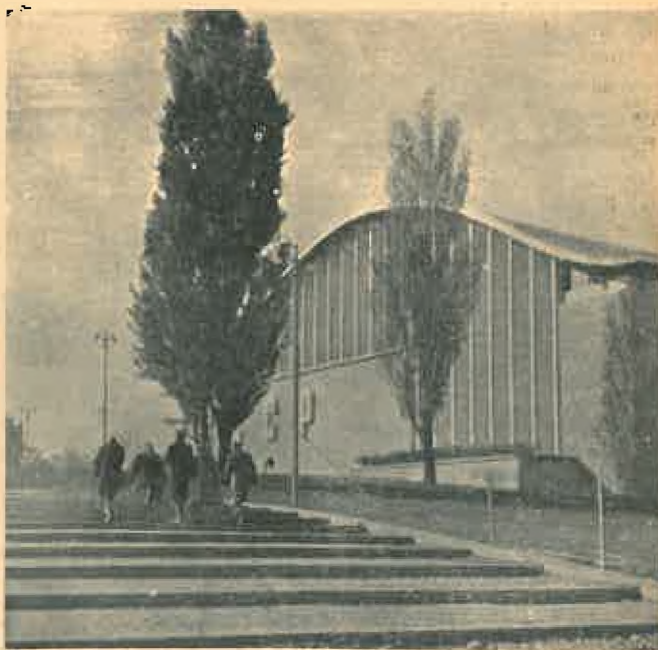
Fațada dela sud
