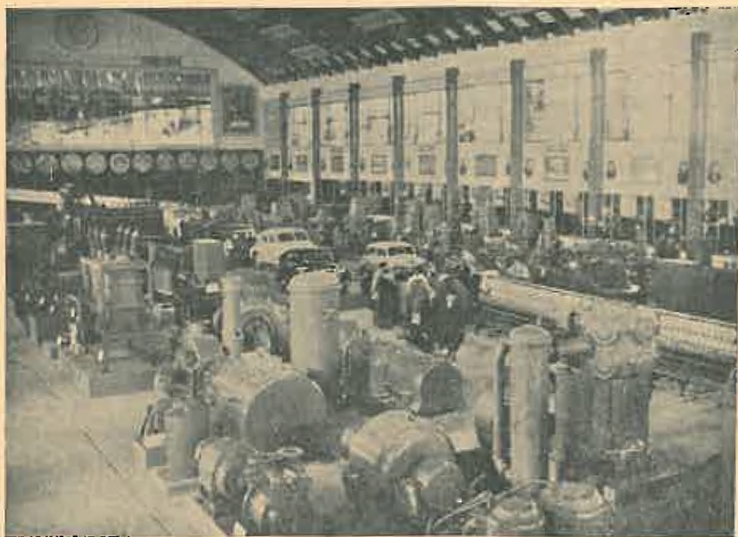
Vedere generală interioară: Hala mașinilor.
