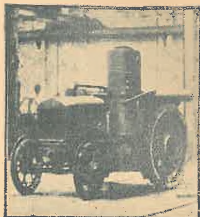
Fig. 19. Tractoare cu motoare pentru gaz de lemn.
