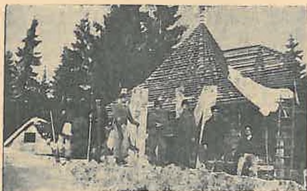
Fig. 2. — Cabană de vânătoare în construcție la Ocolul Silvic Lăpușna, jud. Mureș. (Clișeu I. Man)
