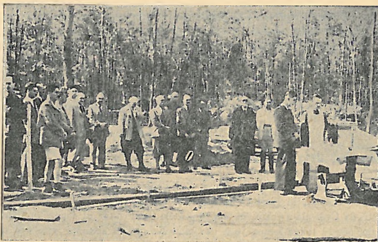
Fig. 2. — Oficierea serviciului religios cu ocaziunea punerii pietrei fundamentale a pavilionului
