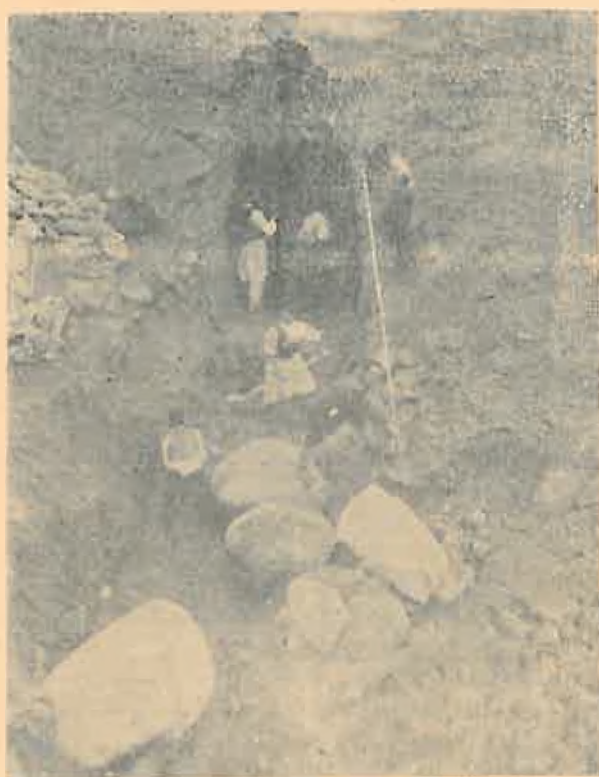
Fig. 4. — Perimetrul Globurău—Mărcu. Lucrări de fundație și încastrare la barajul No. 6
