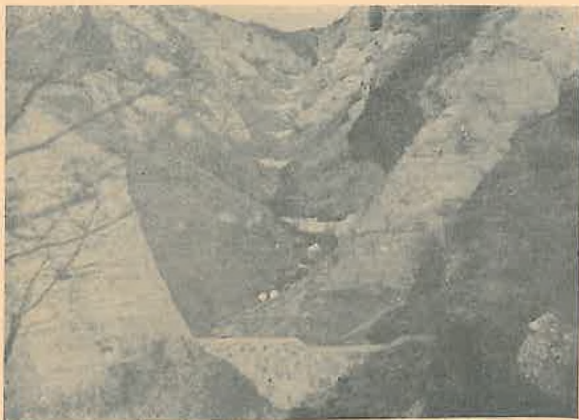
Fig. 2. — Perimetrul Globurău—Matca Barajul No. 2 în construcție.
