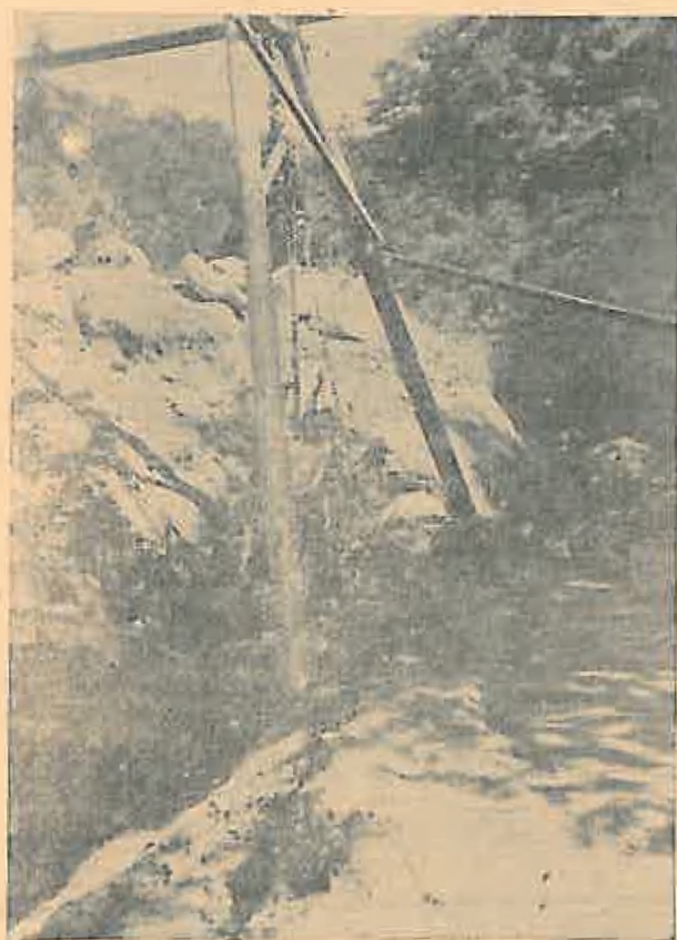
Fig. 5. — Perimetrul Globurău—Matca. Un baraj cu mortar de ciment.
