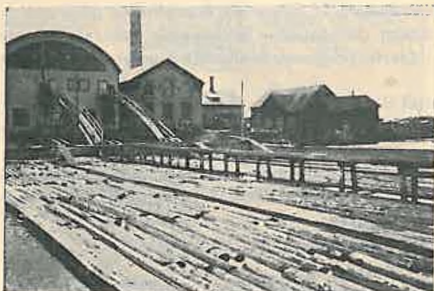
Fig. 2. — Fabrica de cherestea Kalix (Suedia). Depozitul de bușteni — rampa de încărcare—
