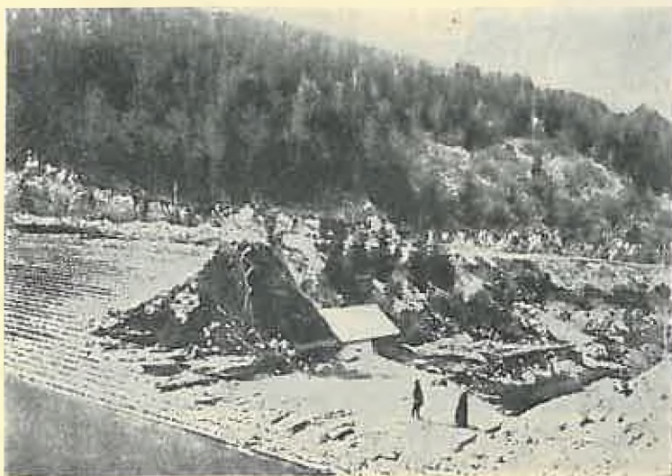
Fig. 10. Rupta, văzută din amonte.
