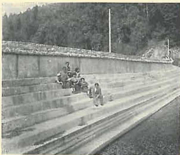
Fig. 12. Suprafața digului din spre apă, betonată în 1935.
