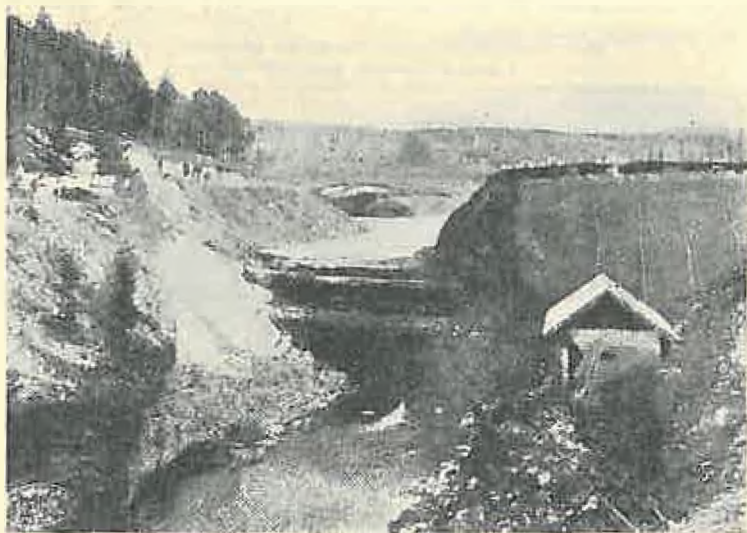
Fig. 11. Ruptura digului, văzută din aval.
