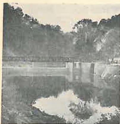
Fig. No. 2. — Barajul: în dreapta, grătarul pe unde intră apa în bazinul «deversorului» și înaintează spre gura conductei.
