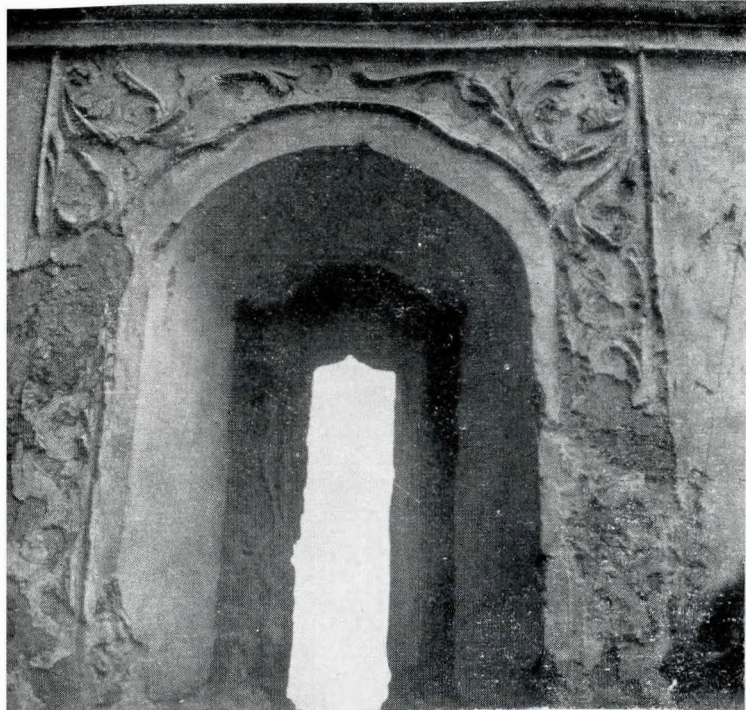
Biserica Albă. Detaliu de decor în stucatură la chenarul ferestrelor — interior.
