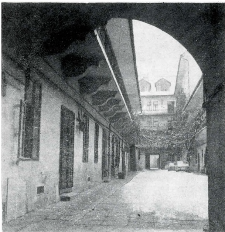
Fig. 8. Str. P. Groza nr. 6 — situația actuală.
