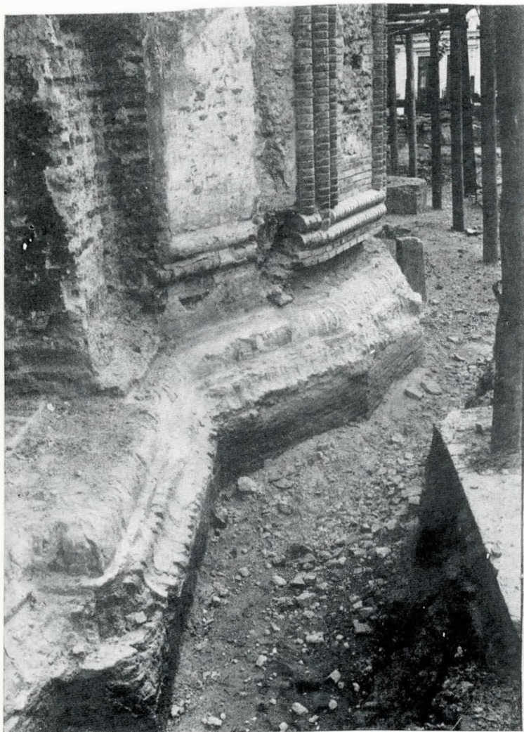
Fig. 3 Biserica Crețulescu din București, restaurată de C.M.I. între 1934—1936, arh. Stefan Balș. Dezvelirea soclului pe latura de nord, între absida laterală și altar, prin coborîrea la nivelul de călcare. Foto W. Weiss, 1934, elisen C.M.I., fototeca D.M.I.
