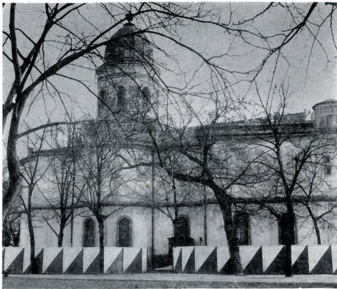
Fig. 12. Fațada nord (situația din 1976)
