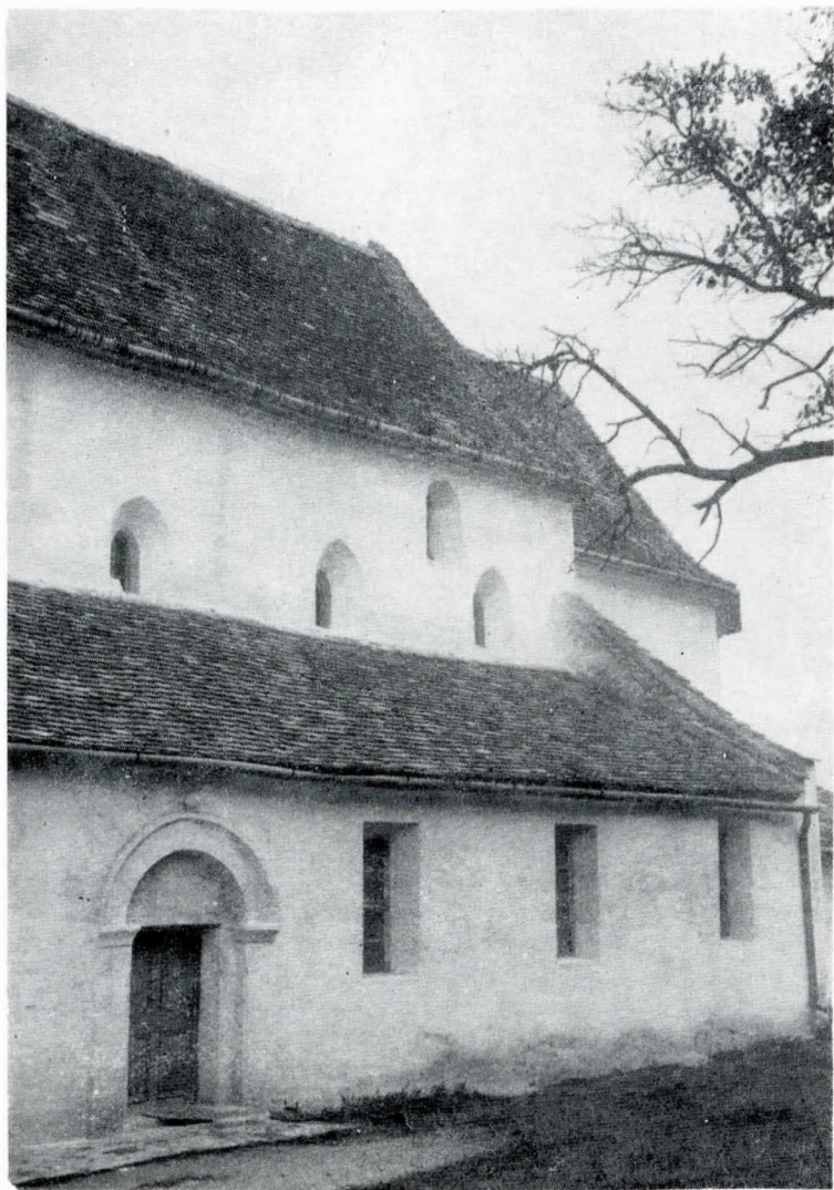
Vurpăr, biserica ev. C.A. Fațada de sud.
