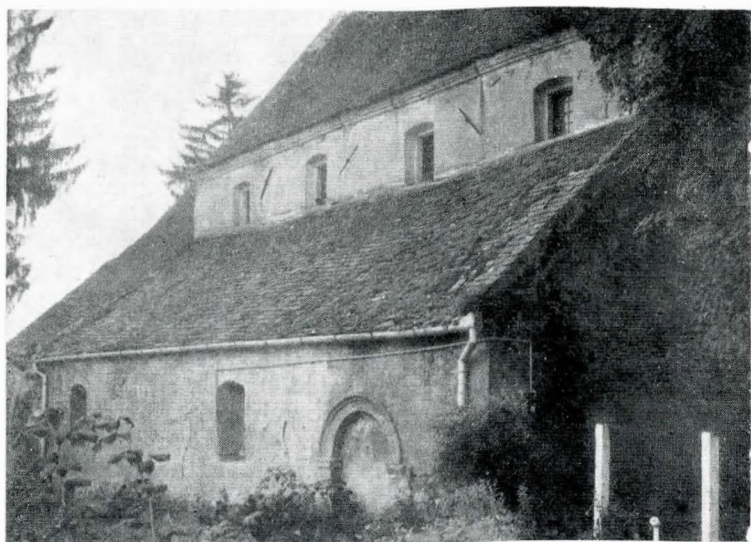
Roșia, biserica ev. C.A. Fațada de nord.
