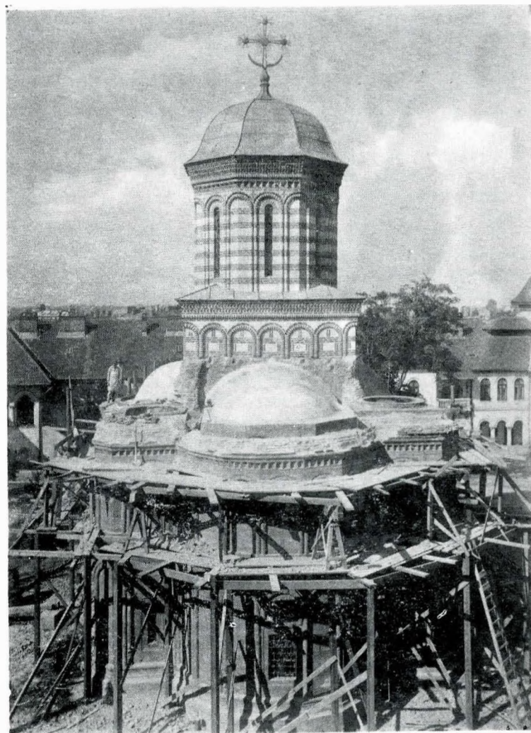
Fig. 1 Biserica Mihail Vodă din București, restaurată de C.M.I. între 1928—1935, arh. Em. Costescu. Vedere dinspre est în 1931. Este terminată refacerea în zidărie a turlei pantocrotorului. În curs de execuție, cornișa generală și bazele celor două turle ale pastoforiilor. Foto N. Tațu, elişeu C.M.I., fototeca D.M.I.
