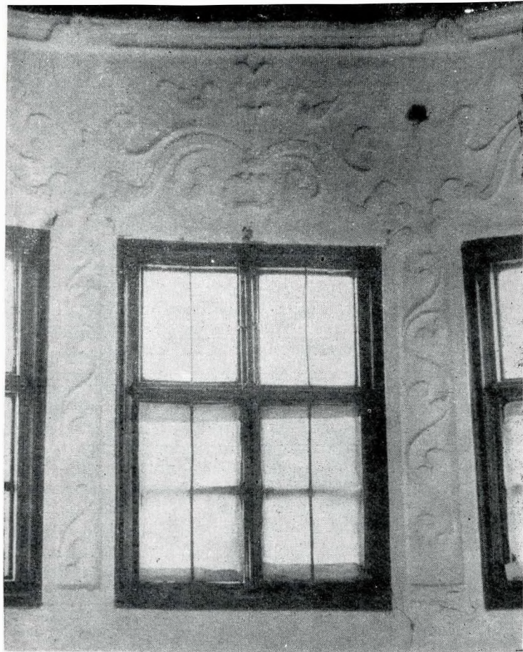
Ornamente în stucatură de la ferestrele sacnasilui casei Hagî Prodan
