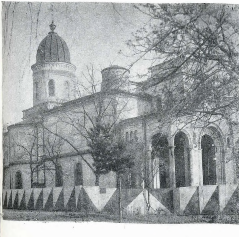
Fig. 10. Fațada nord-vest (situația din 1976)
