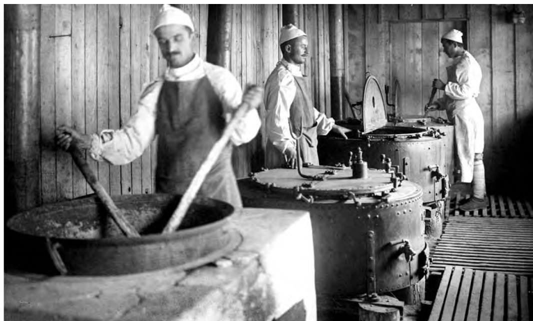
Interiorul unei manutanțe
