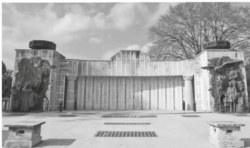
■ Mausoleul Eroilor de la Mărăști
