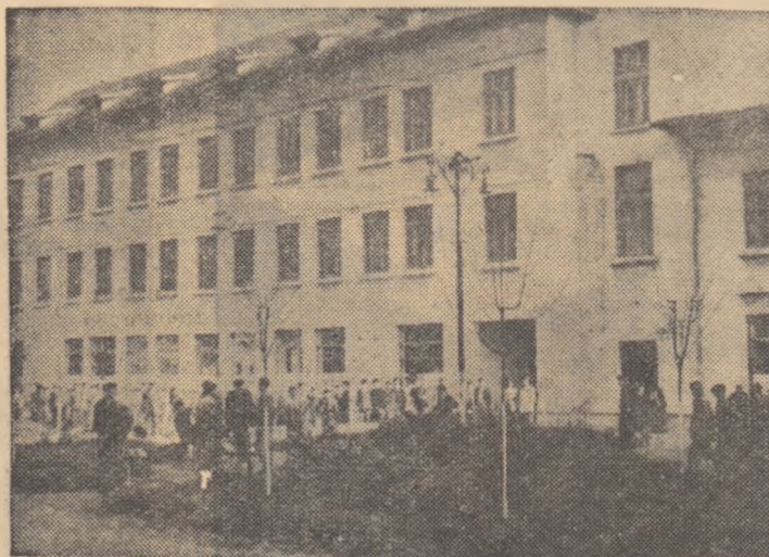
Clădirea Centrului școlar agricol din Buzău
