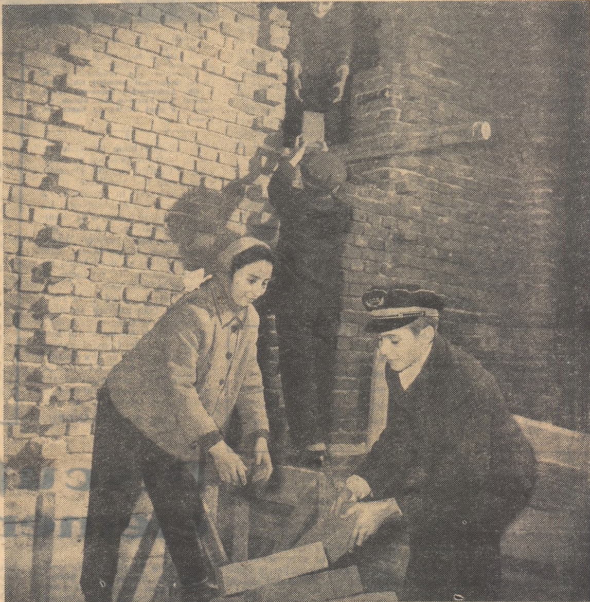
Brigada patriotică a elevilor de la școala de 7 ani Costeasca, din raionul Crivița Roșie și-a luat angajamentul de a contribui la terminarea în cel mai scurt timp a unei noi școli din raion. Iată cîțiva din membrii brigăzii lucrînd pe șantier.
