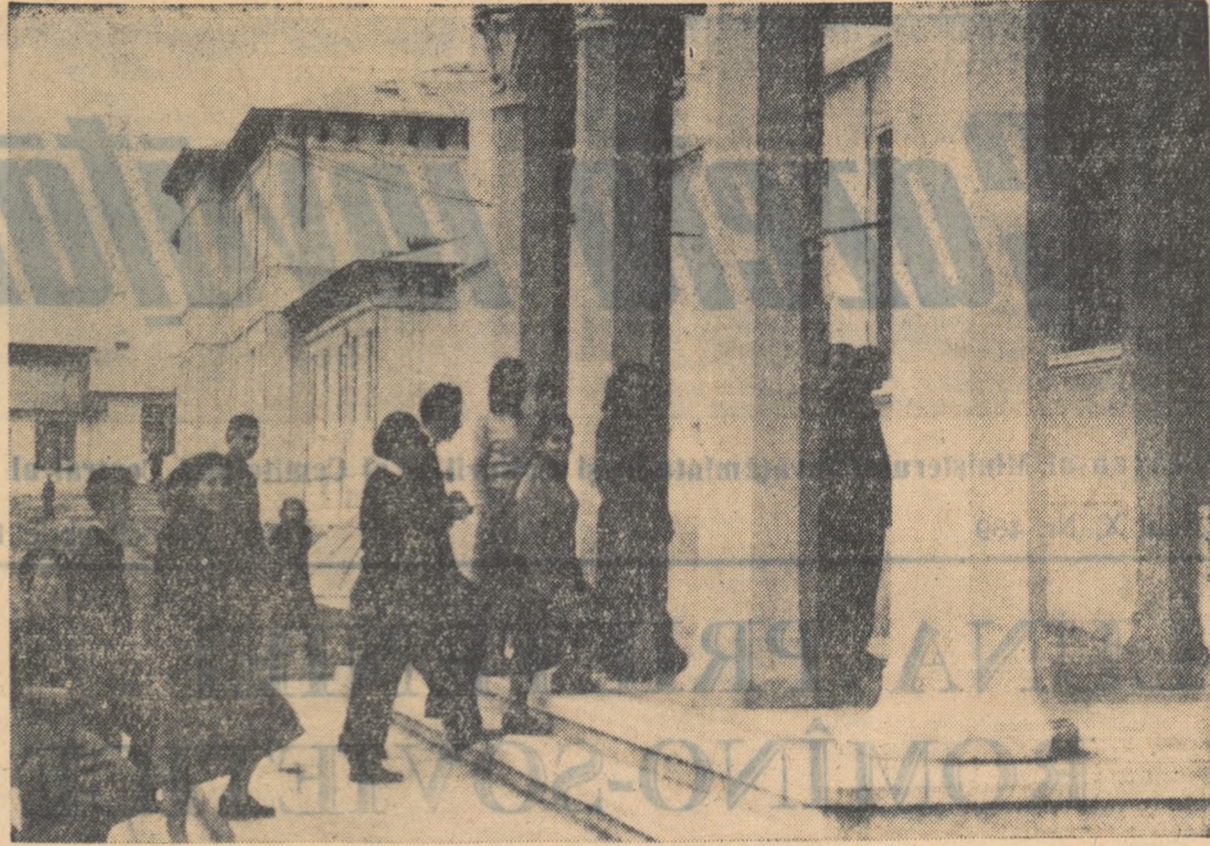
De curînd a fost inaugurată noua clădire a căminului Școlii tehnice de maistri din Galați. Căminul este înzestrat cu dormitoare spațioase, bibliotecă, club, instalații tehnico-sanitare moderne.
