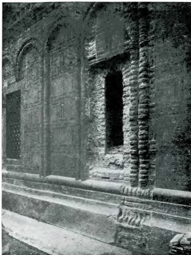
Fig. 13. — În fațada Nord a bisericii se pot compara două ferestre: una lărgită, cu grile de fier și cadru de piatră, iar alta descoperită în forma ei dela început.
