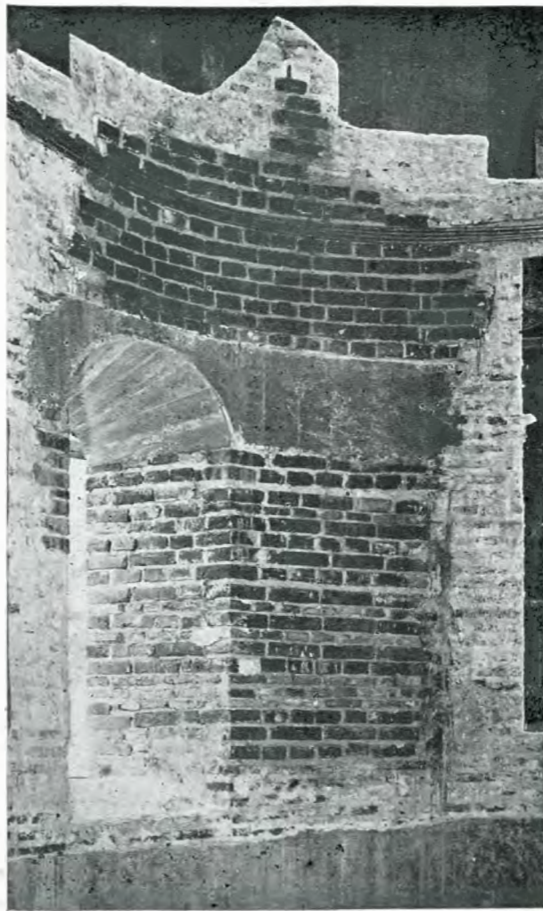
Fig. 35. — Restaurarea ferestrei vechi dela sânul Nord, care cade înclinat pe tâmpla bisericii.
