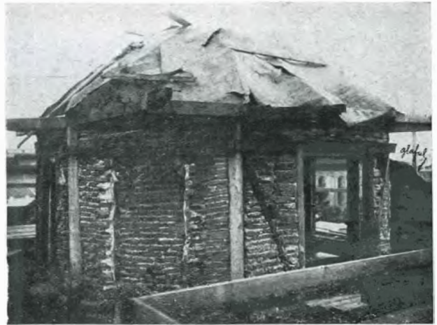
Fig. 19. — Zidul interior al turlei vechi a Pantocratorului, în timpul demontării ei, în anul 1928.
