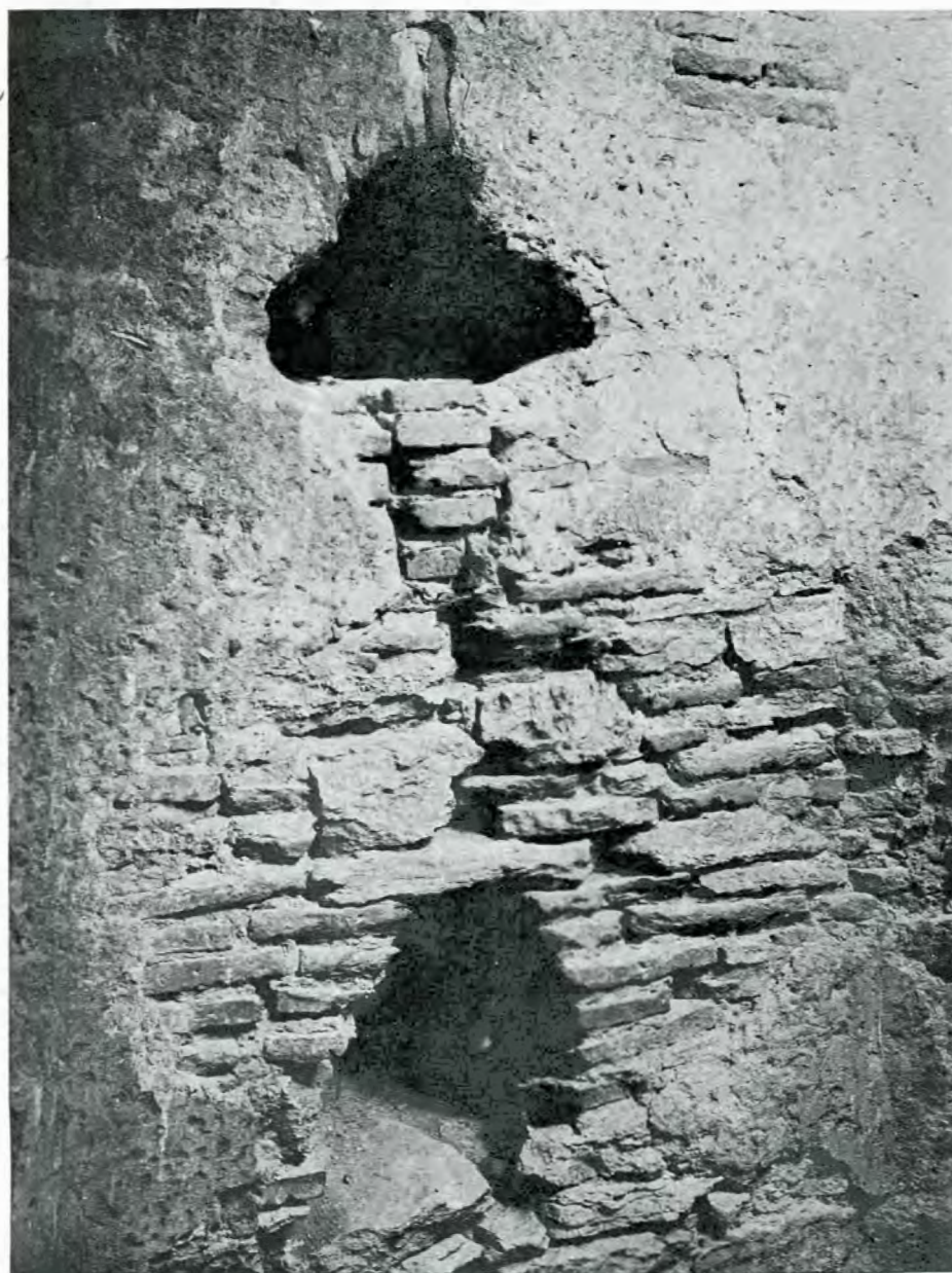
Fig. 8. — Biserica Mucenița din Câmpulung. Peretele Nord-Est al clopotniței văzut din interior.
