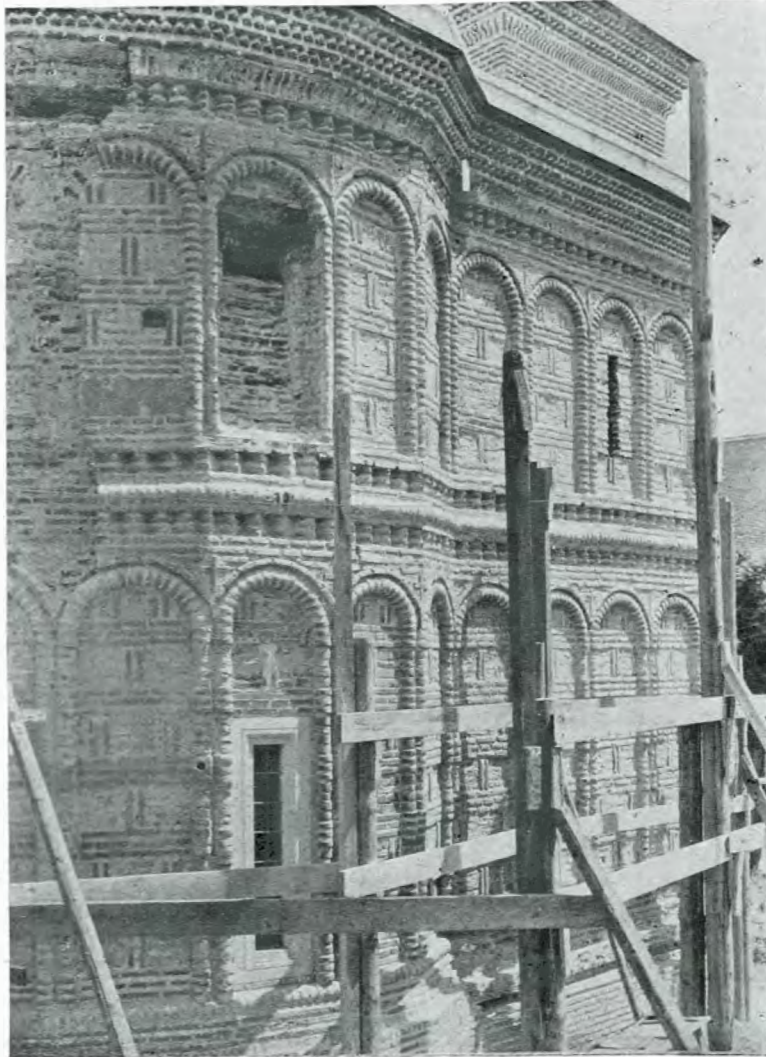
Fig. 36. — În timpul restaurării s'au descoperit ferestrele mici, din registrul superior al fațadelor.
