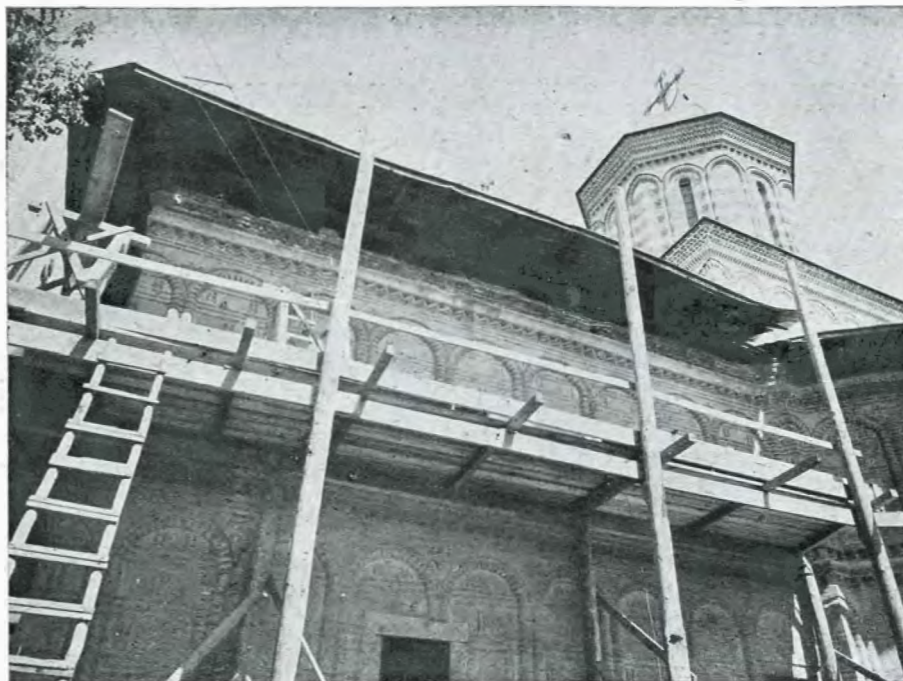
Fig. 25. — Vederea cornișei vechi aflată sub strașina înfundată și formată din trei rânduri de cărămizi cu colț, alternate cu trei rânduri drepte.
