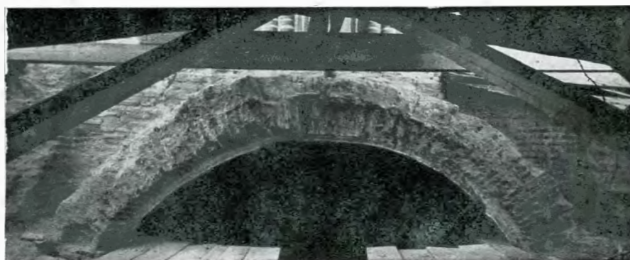
Fig. 31. — Vederea urmelor boltei altarului și a turlelor mici. Fotografia este luată în podul altarului.
