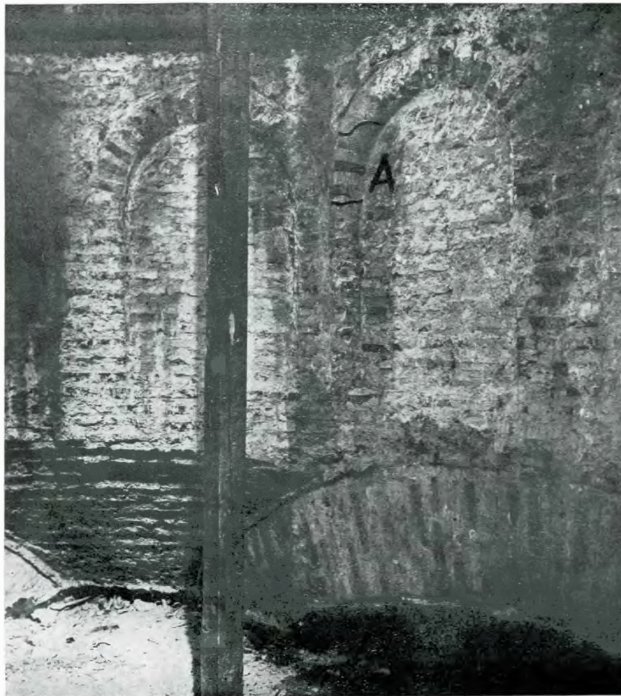
Fig. 38. — Arcadele mici aflate la baza interioară a turlei Pantocratorului. În A se văd urmele frescei originale în alb și roș.
