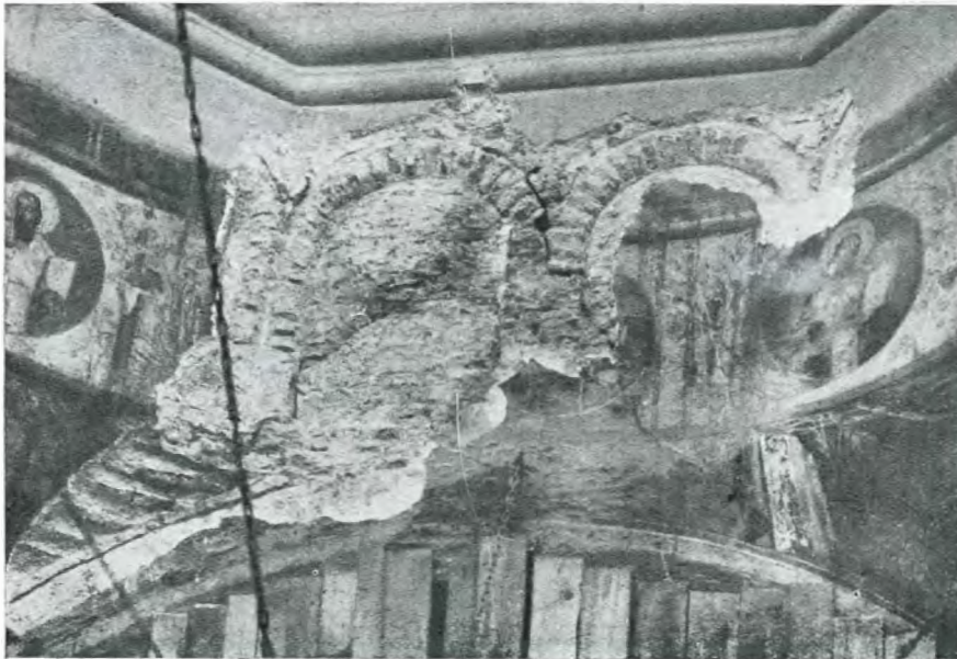
Fig. 19 bis. — Arcadele decorative din interiorul patului turlei Pantocratorului, în timpul restaurării din anul 1928.
