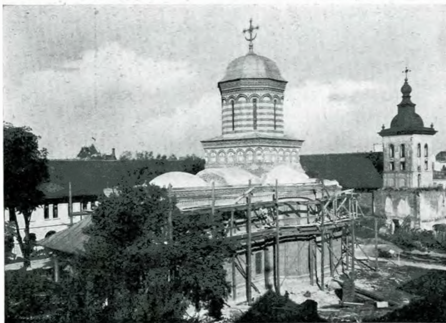
Fig. 32. — Vedere luată în timpul restaurării cornișei, bolților și turlelor mici. — În fund se vede clopotnița veche.
