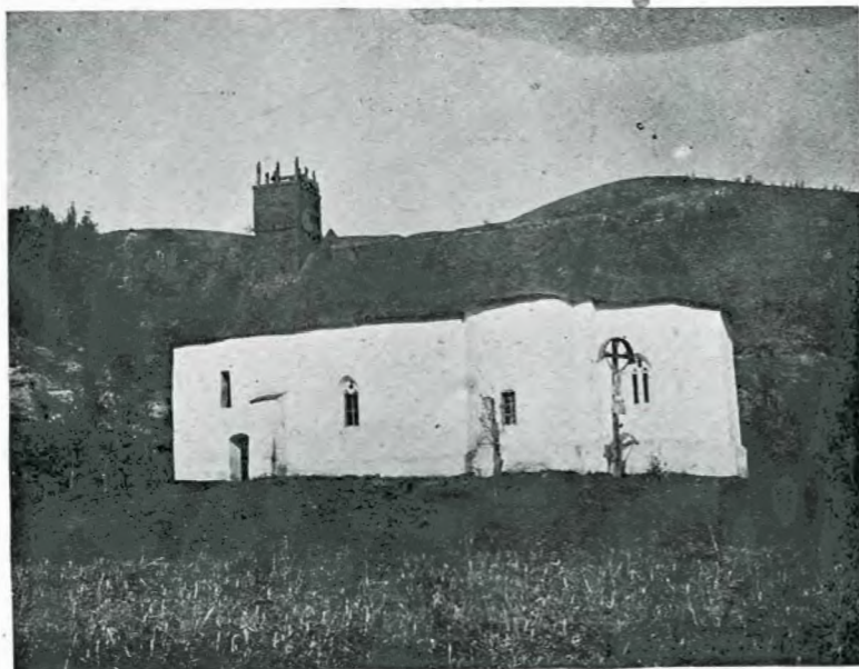
Fig. 1. Biserica lui Ștefan cel Mare dela Vad: Vederea din spre sat.
