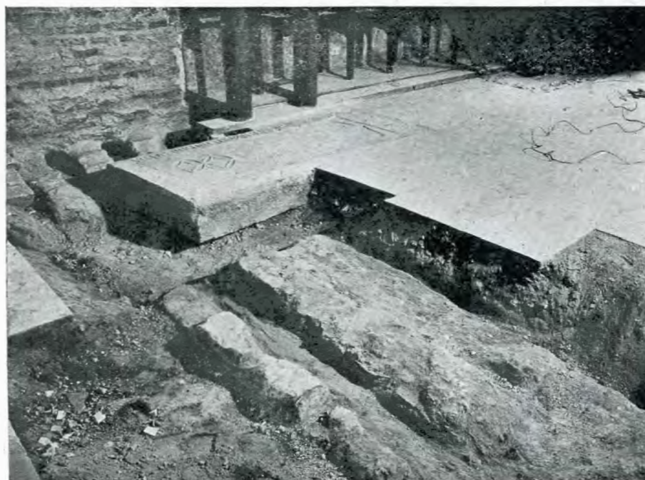
Fig. 26. — Fundația veche de cărămidă a zidului dintre naos și pronaos.
