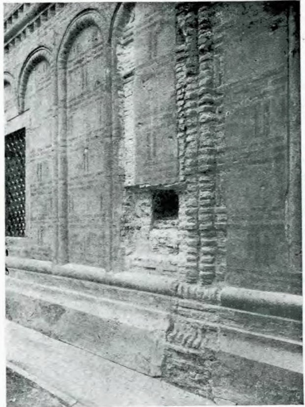
Fig. 10. — Tencuiala ulterioară vâpsită, care s'a executat peste fațadele aparente ale bisericii.
