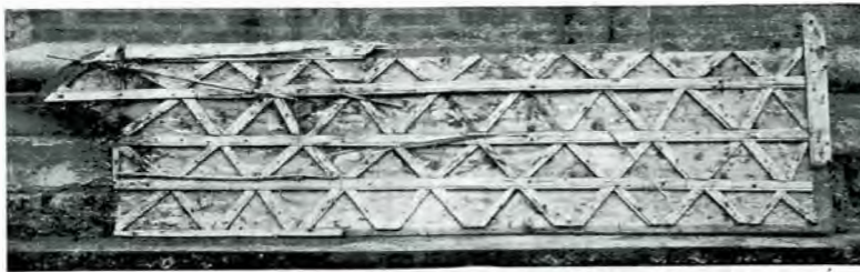
Fig. 12. — Bolți de scânduri, decorate cu șipci-fălțuite și văpsite în culoare verde.
