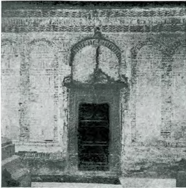
Fig. 9. — Cadrul de piatră al ușii principale și arcadele de cărămidă din pridvor, care au fost cioplite.
