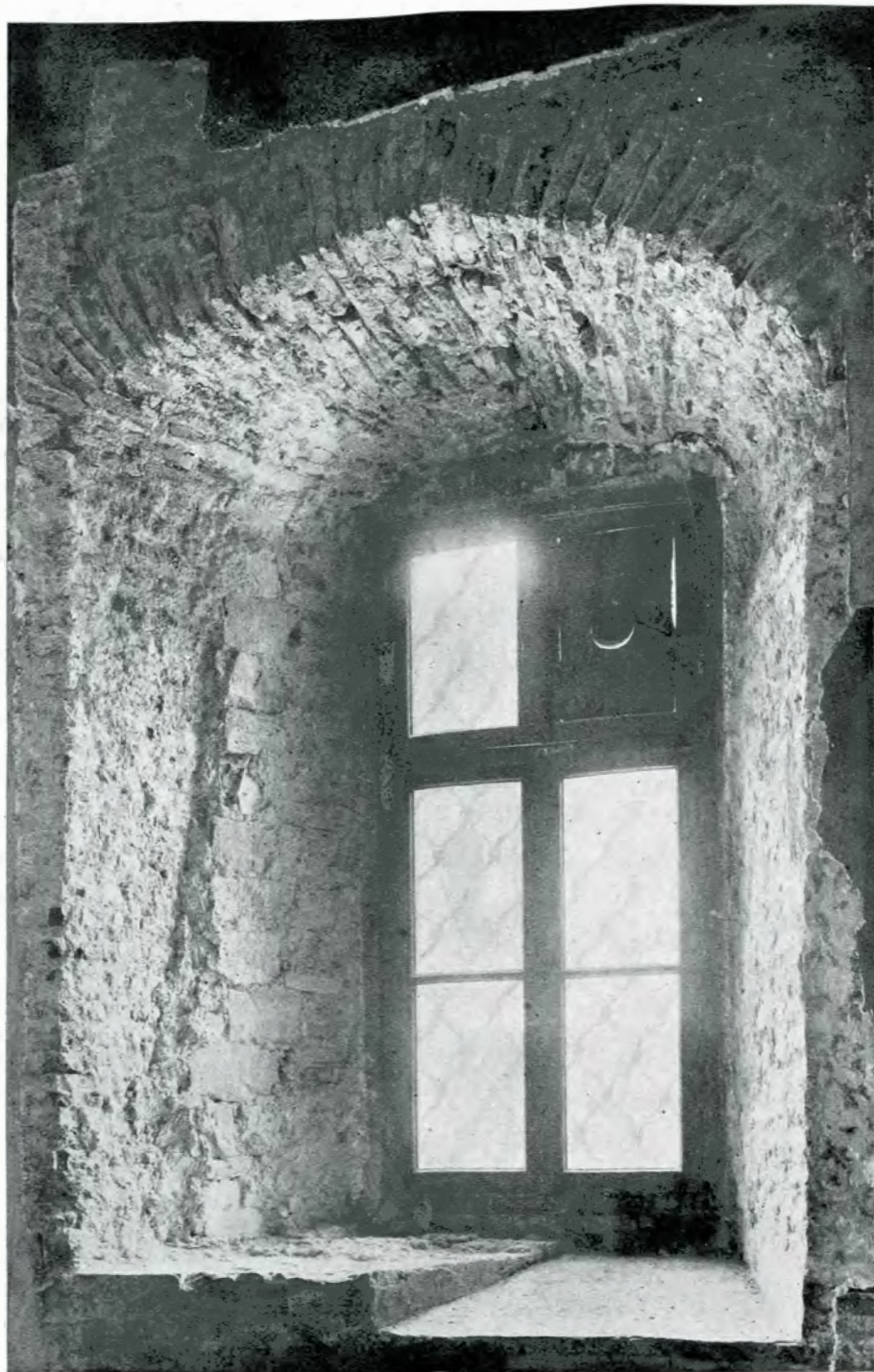
Fig. 34. — Fereastra Nord lărgită, din camera mormintelor. Jos se vede urma exactă a ferestrei vechi.
