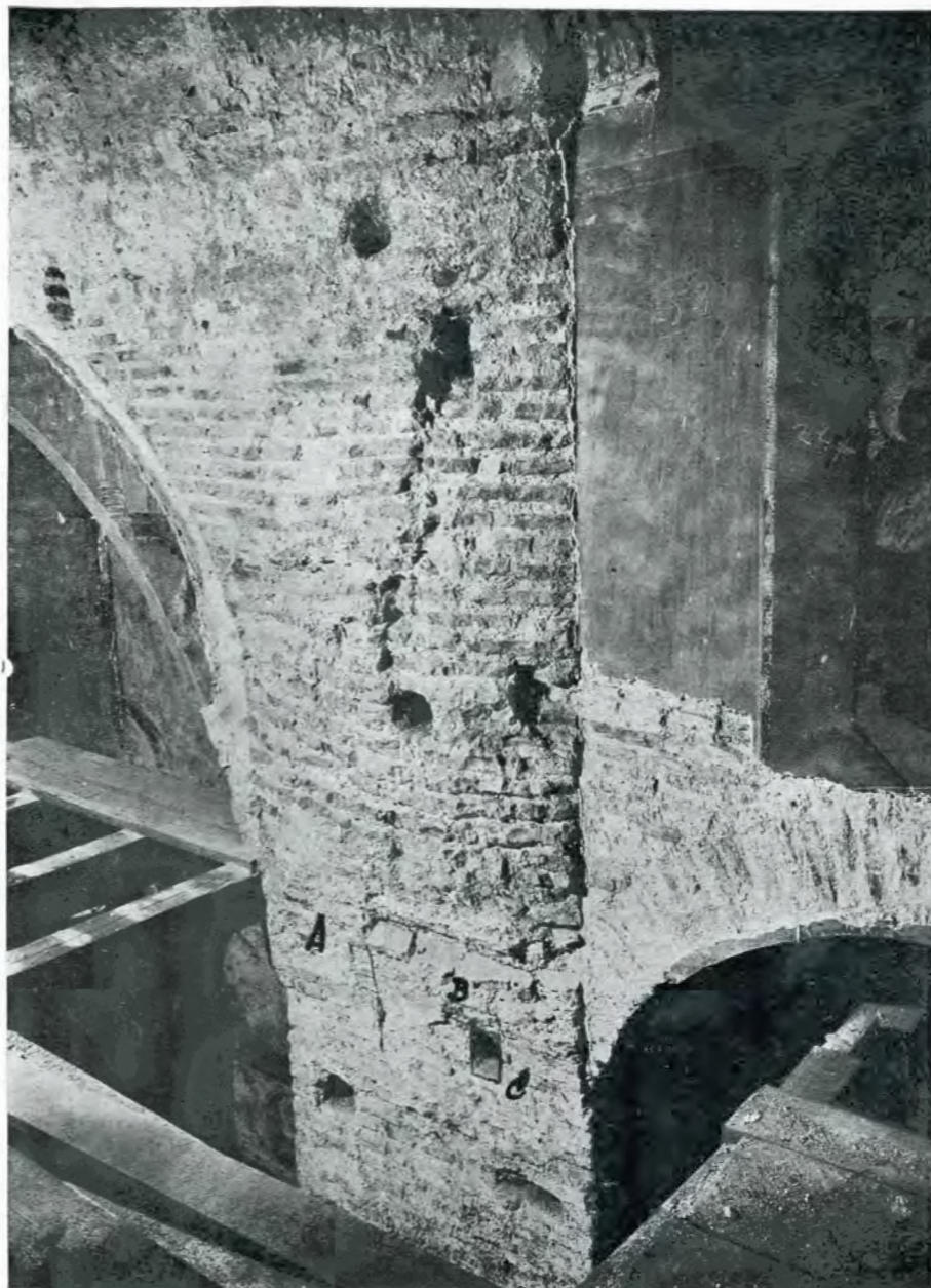
Fig. 27. — Vederea pendentivilor ciopliți din pronaos. — In A se vede urma arcului de susținere al calotei, în B se vede imposta unuia din cele trei arcuri mici dintre coloane și în C se vede locul tirantului de lemn. Celelalte găuri sunt făcute ulterior pentru schelă.
