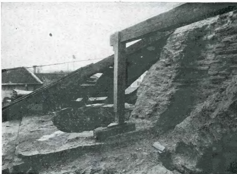
Fig. 23. — Vedere luată în podul bisericii spre diaconicon, unde se vede baza turlei mici și a masivului vertical după care s'au restaurat turlele mici actuale.
