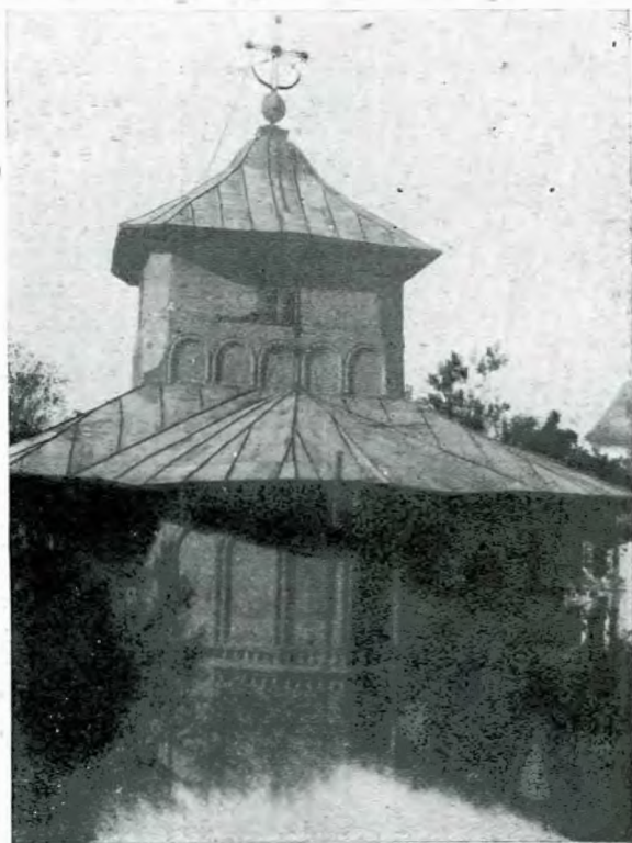
Fig. 7. — Turla veche văzută dela altar, înainte de restaurare.
