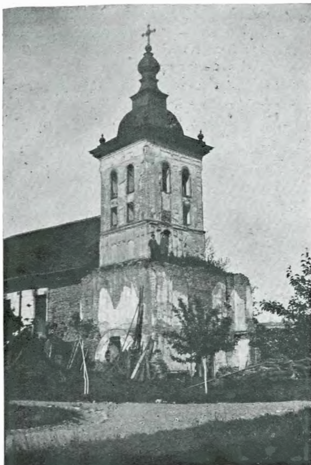
Fig. 39. — Clopotnița veche. Vederea fațadelor Sud-Vest
