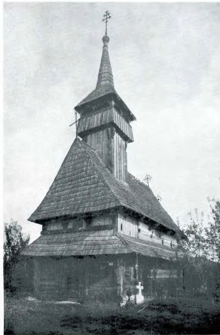
Fig. 96. — Biserica din Bârsana. Vedere din spre Sud-Vest.
