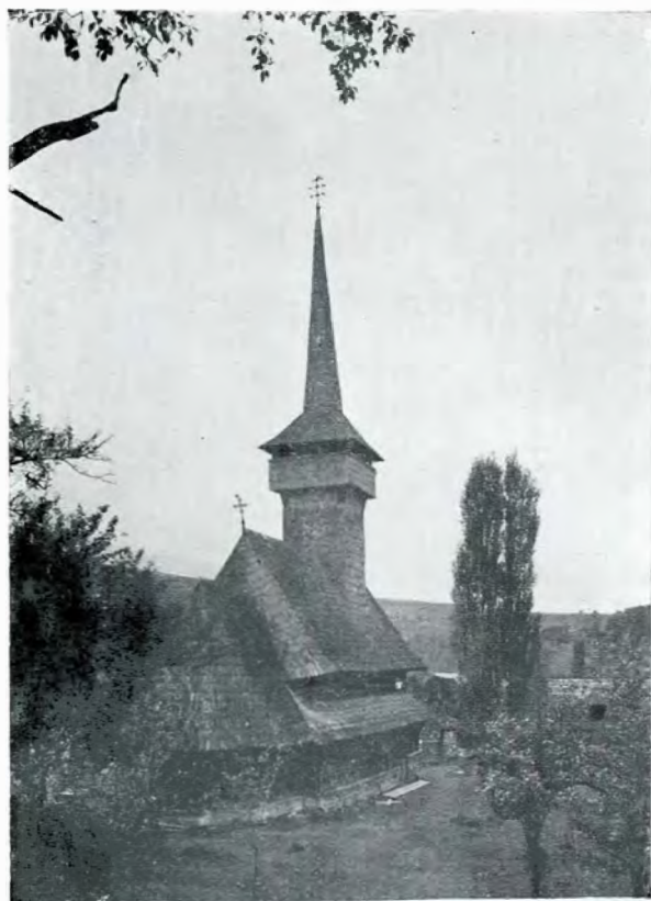
Fig. 227. — Biserica din Borșa. Vedere din spre Nord-Est.
