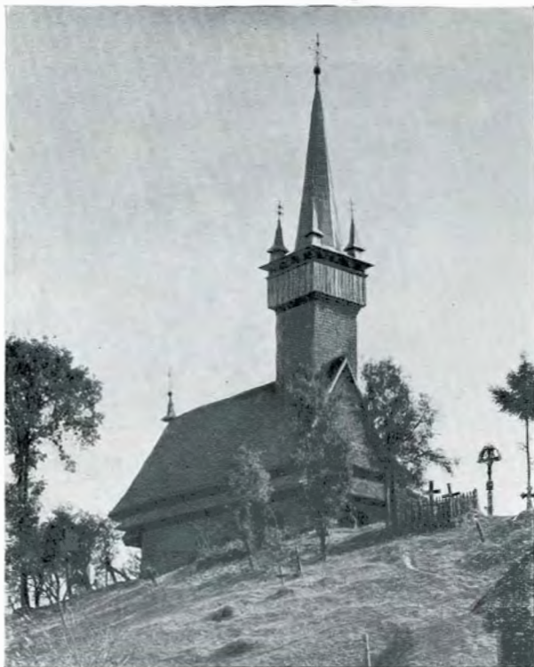
Fig. 241. — Biserica din Apșa-de-Jos. Vedere din spre Nord-Vest.
