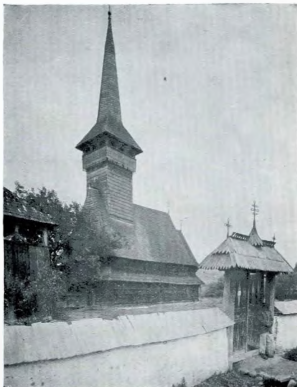
Fig. 172. — Biserica din Cuhea. Vedere laterală.
