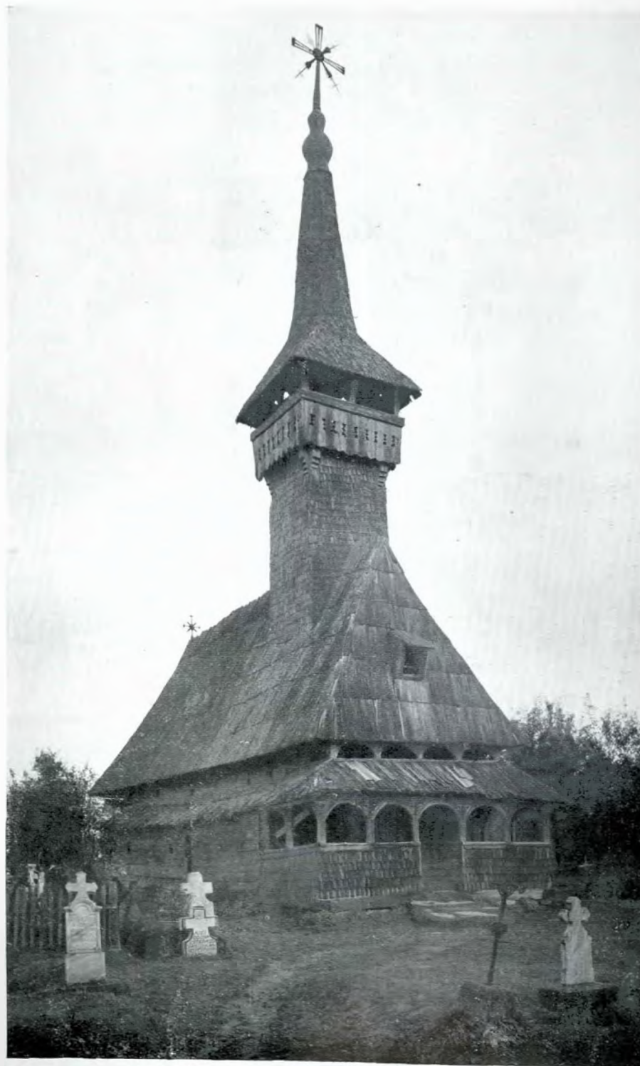
Fig. 90. — Biserica din Oncești. Vedere din spre Sud-Est.
