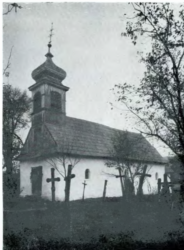
Fig. 135. — Biserica din Strâmtura. Vedere din spre Sud-Vest.
