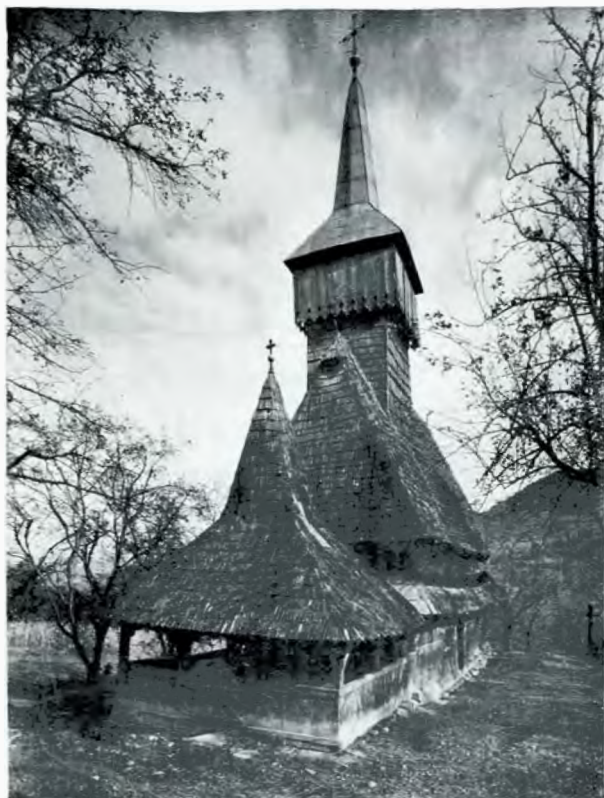
Fig. 118. — Biserica din Văleni. Vedere din față.
