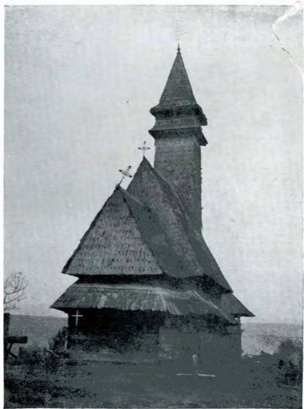
Fig. 253. — Biserica din Apșa-de-Mijloc. Vedere din spre Nord-Est.
