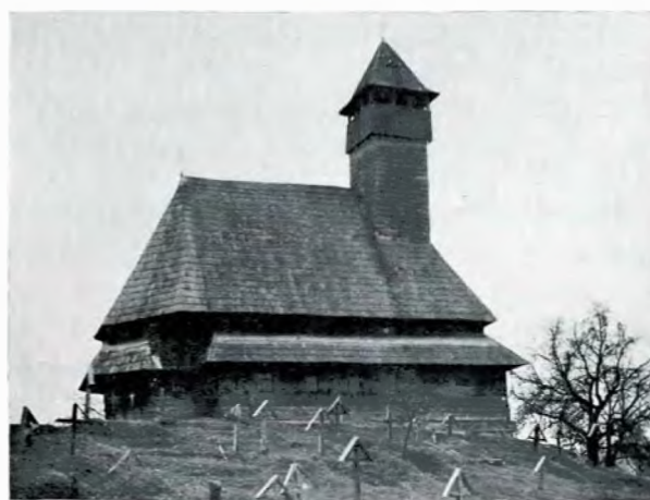
Fig. 246. — Biserica din Apșa-de-Mijloc. Vedere laterală.
