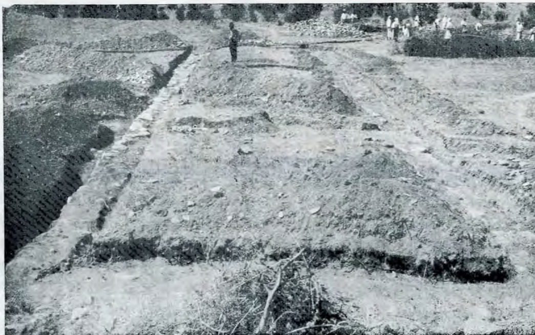
Fig. 11. – Clădirea interioară, la S. de via decumana Casa allo S della via decumana.
