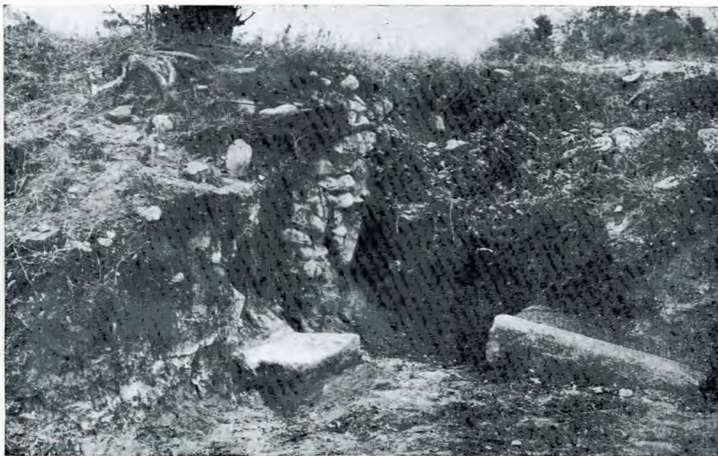
Fig. 8. – Pragul porții de Sud. La soglia della porta sul lato Sud.
