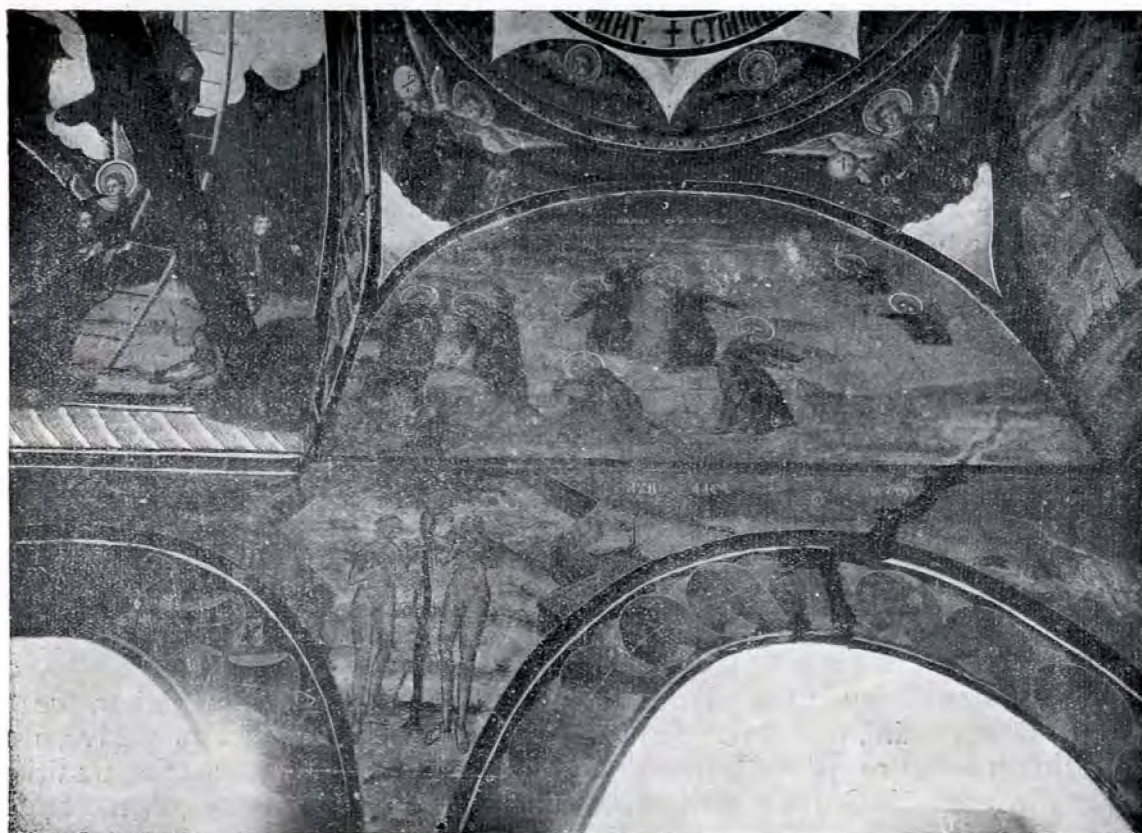
Fig. 12. – Biserica din Chițorani-Prahova. Pilda secerișului. Adam și Eva în Raiu. Pictură în pridvor.
