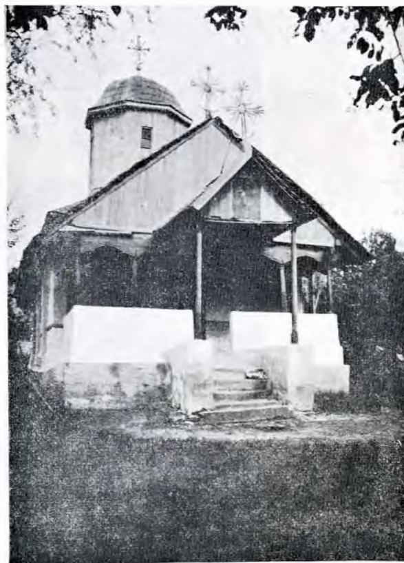
Fig. 2 - Biserica de lemn din Valea Orlei com. Chițorani-Prahova. Vedere din față.
