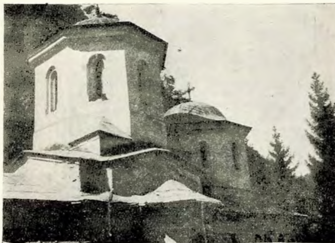
Fig. 6. — Vedere asupra turelor și a frontoanelor triunghiulare la baza celei de pe naos.
