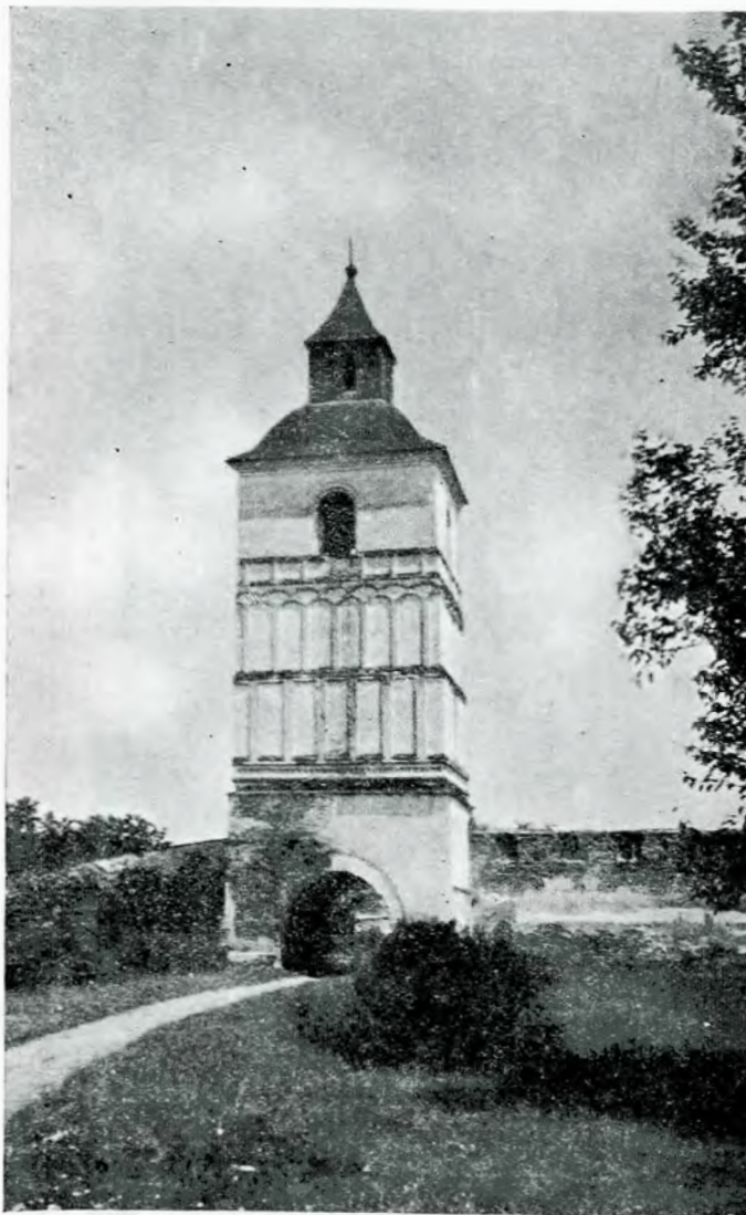
Fig. 12. — Mănăstirea Strehaia, Mehedinți. Vederea clopotniței.
