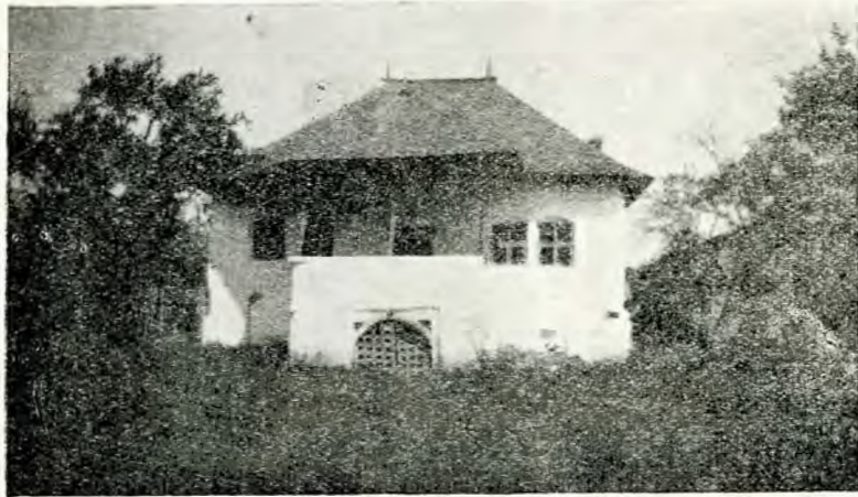
Fig. 3. — Casă de pe Valea Teleajenului.
