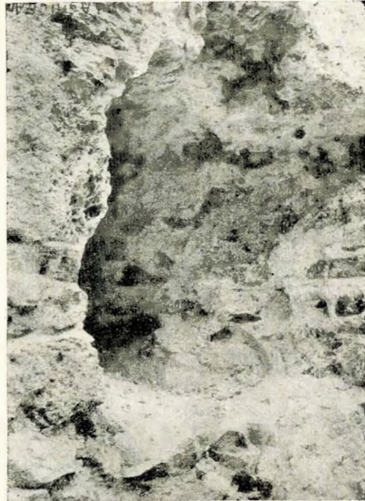
Fig. 9. — Sondaj în zidul pronaosului.
