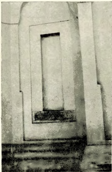
Fig. 13. — Biserica Sf. Elefterie. Fațada Nord, cu fereastra astupată restaurată.
