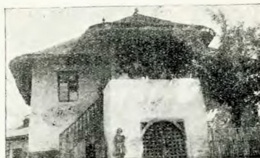
Fig. 5. — Casă de pe Valea Teleajenului.
