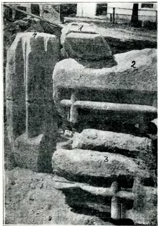
Fig. 84. Sf. Ioan din Vaslui Chenare de ferestre
