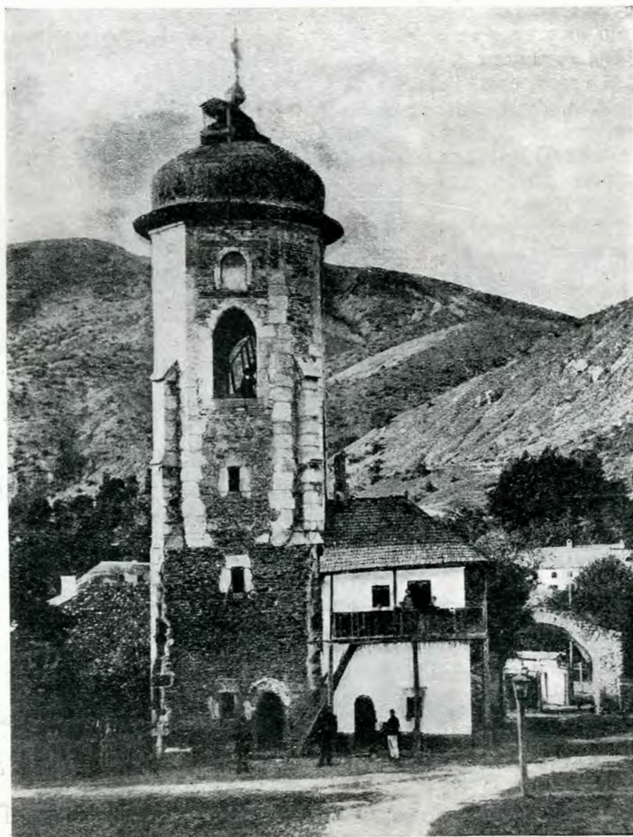
Fig. 227. Tarnal-clopotniță al bisericii Sf. Ioan din Piatra înainte de restaurare
