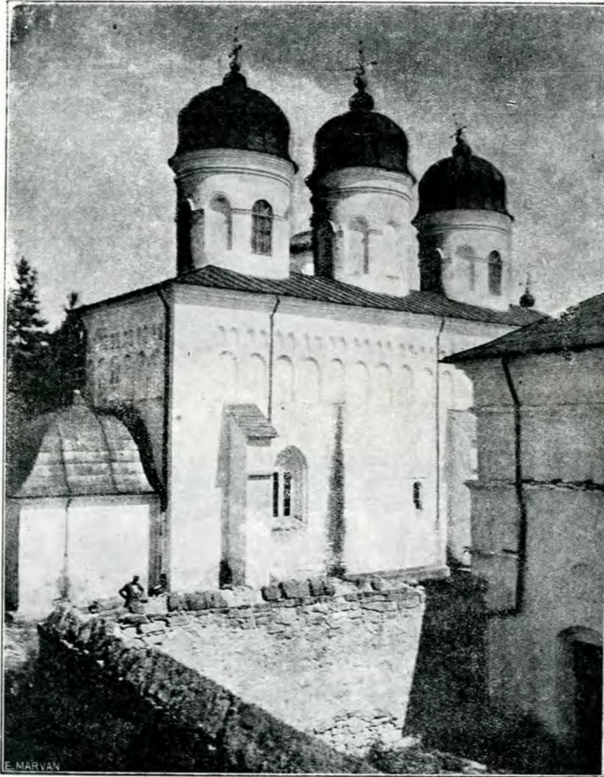
Fig. 172. Dobrovăț, Vedere din spre Sud-Vest
