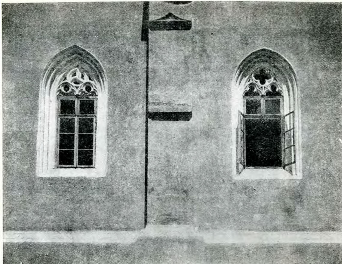
Fig. 141. Mănăstirea Neamțului, Ferestrele Săd ale pronaosului
