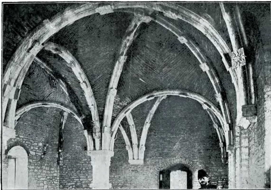
36. Sala gotică (restaurată).
