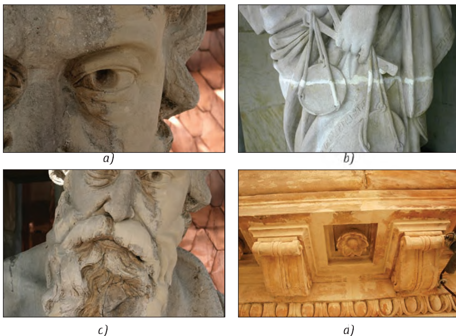
Fig. 22 - Exemple de chituiiri, plombări și reconstrucții volumetrică cu mortar special de restaurare; zonele deschise din (a), (b), (c) și (d), reprezintă completările efectuate, înainte de retușul cromatic, fațada Lipsani / Examples of fillings, locking and volumetric reconstructions using special restoration mortar; the light areas in (a), (b), (c) and (d), are completions made before the chromatic integration, the Lipsani facade.
