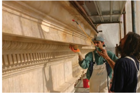
Fig. 24 - Tratamentul protectiv al suprafetelor de calcar cu o substanta hidrofuga, fațada Lipscani / Protective treatment of the limestone surfaces with a water repellent product, the Lipscani facade.
