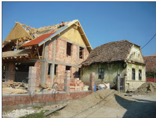
Fig. 8 - Biertan. Casa nr. 36 din cartierul românesc, demolată în decembrie 2011, fără autorizație / Biertan. House no. 36, in the Romanian quarter, demolished in November 2011, without authorization
