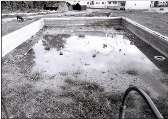
Fig. 16 Fostul bazin de înot / L'ancienne piscine communale
