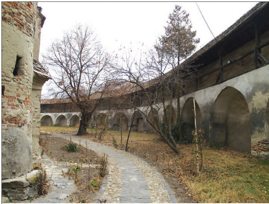
Fig. 4 - Valea Viilor. Biserica fortificată, zidul de incintă cu drum de strajă și sistemul de drenaj refăcut în 2011 / Valea Viilor. The fortified church, the enclosure wall with the watch road and the drainage system, restored in 2011
