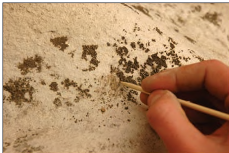
Fig. 16 - Îndepărtarea manuală a crustelei, fațada Lipscani / Manual removal of biocrusts., the Lipscani facade.
