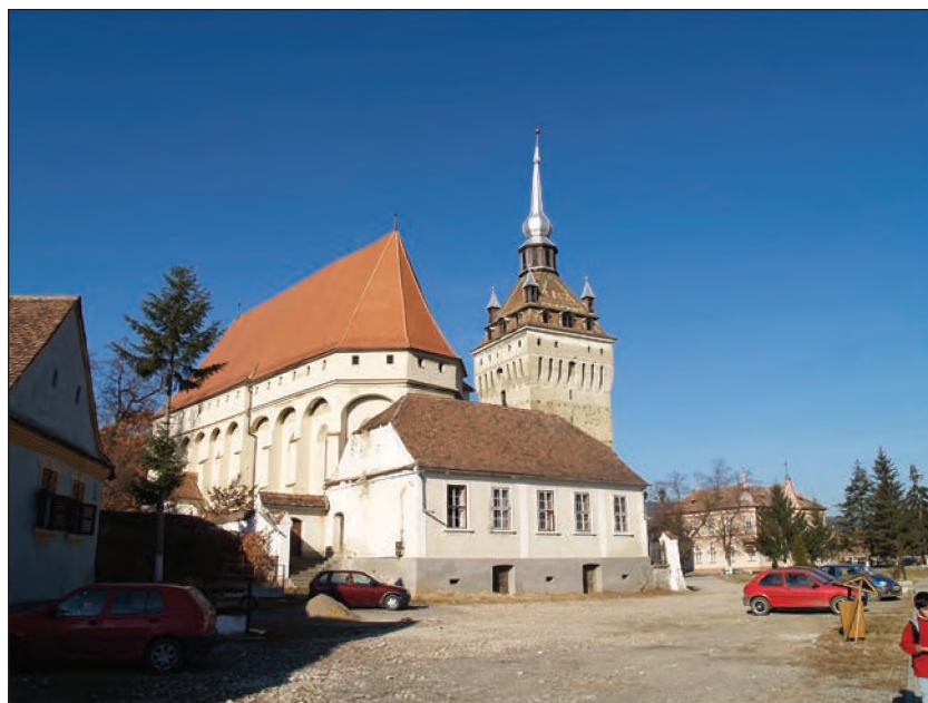
Fig. 3 - Saschiz. Biserica fortificată, restaurată 2000- 2011 și turnul clopotniță, inclus în Planul Național de Restaurare; Saschiz. The fortified church restored 2000-2011 and the bell tower, put on the National Restoration Plan (PNR)
