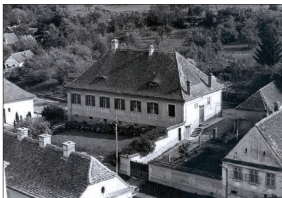
Fig. 9 Casa parohială evanghelică / Maison paroissiale évangélique
