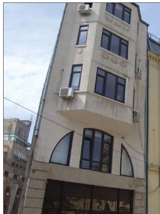
Fig. 52. Casa de pe strada Franceză nr. 24 - clădirea actuală
