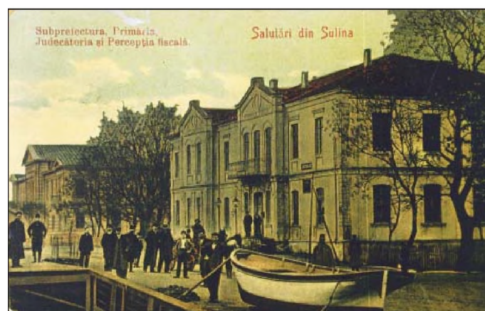
Fig. 4. Clădirea primăriei, subprefecturii, judecătoria și percepției fiscale – astăzi dispărută, carte poștală de la înc. sec. XX
