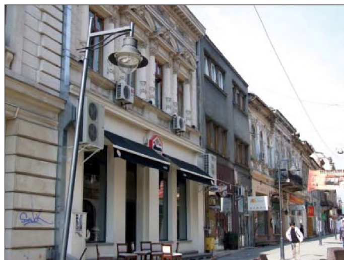
Fig. 3 - Exemplu de “degradări estetice”
