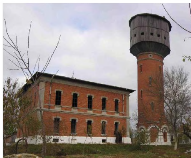
Fig. 16. Turnul de apă și clădirea filtrelor și bazinelor de decantare în anul 2008*
