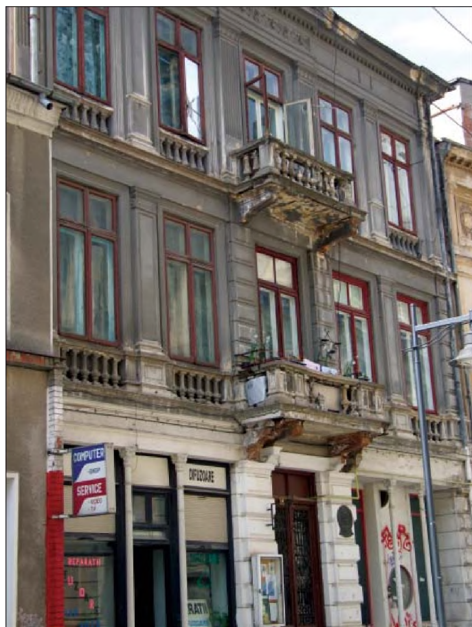
Fig. 7 - Degradările cel mai des întâlnite pe întreaga stradă sunt la balcoane
