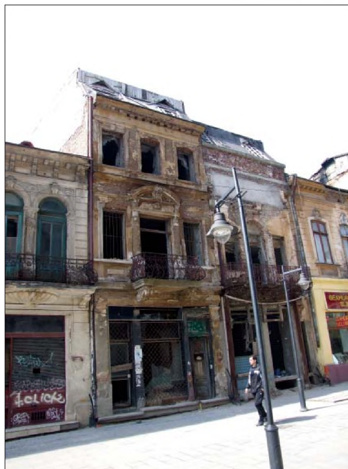
Fig. 4 - Lucrări începute și nefinalizate
