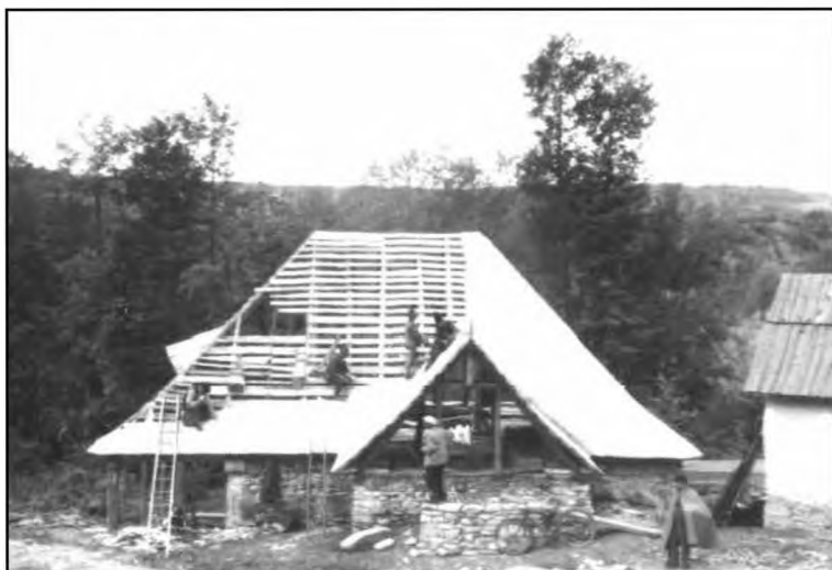
Fig. 22 Șarpanta. Refacere 1939. Arhiva fam. Kretzulescu Warthiadi
