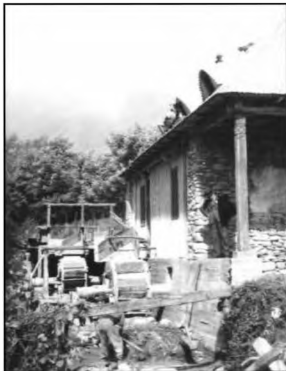
Fig. 9bis Fațada de est, roțile hidraulice. 1939. Arhiva fam. Kretzulescu Warthiadi
