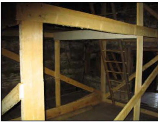
Fig. 9 Biserica de lemn din Bârsana, schelă pentru lucrările de restaurare a picturii
