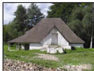
Fig. 15 Fațada de est. 2006
