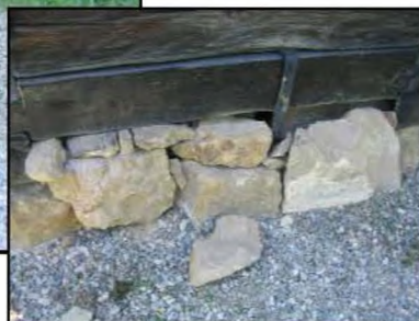
Fig. 7 și Fig. 8 Biserica de lemn din Bârsana, dislocări
