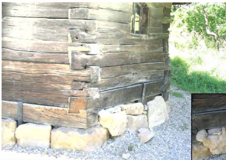
Fig. 7 și Fig. 8 Biserica de lemn din Bârsana, dislocări
