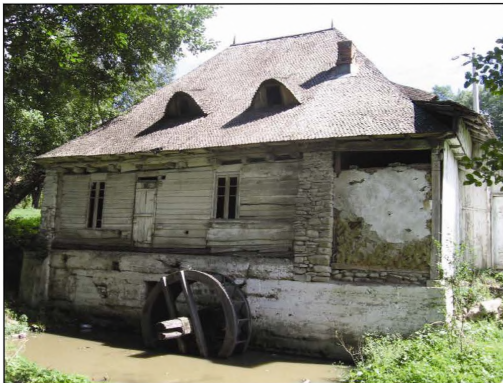
Fig. 10 Fațada de est. Roata hidraulică. 2006
