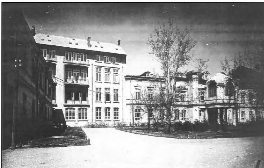
Fig. 1 Foto post 1926 - arte 1950. Corpul central al Spitalului Dr. Caracș. În stânga noul corp A, proiectat de arh. V. Moga și executat în 1926. Fototeca I.N.M.I.
