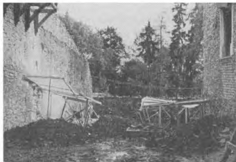
1. Curtea vestică – vedere generală a săpăturilor
