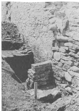
8. Caseta C II – dublare cu cărămidă a zidului despărțitor dintre curți
