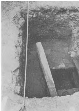
21. Caseta V VII – vedere asupra canalului colector
