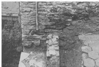
3. Caseta C I – dublare zid despărțitor cu zid cărămidă
