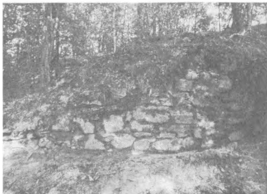
Foto 2 – Cetatea medievală de la Sadu; fragment din zidul cetății în timpul lucrărilor de protejare.
