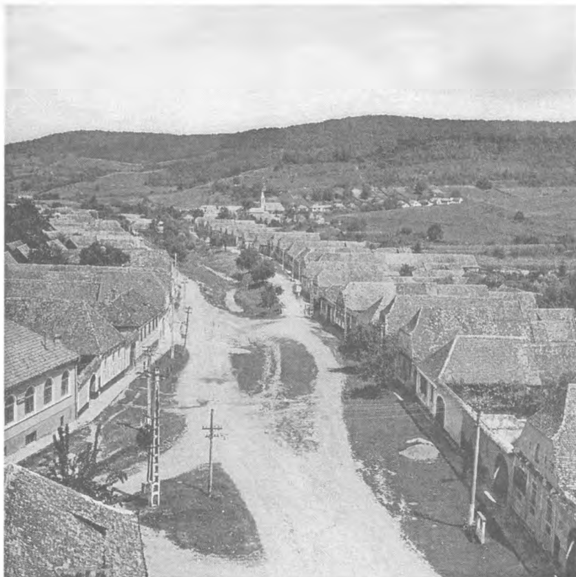
Porțiunea de nord a str. Principale, cu aspect determinat de valea pârâului Copșei (în fundal cartierul românesc)
