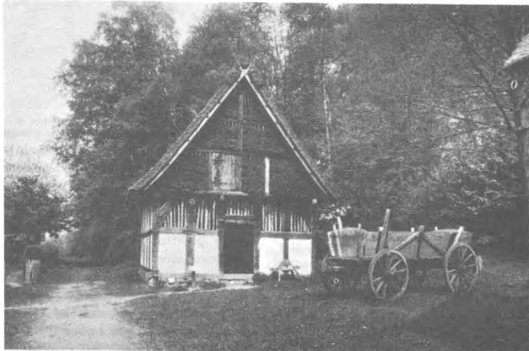
5. Depozit pentru lemn de foc; districtul Minden-Lübeck, construit în 1625. Prin tehnica de construcție, era asigurată ventilația spațiului de depozitare.
