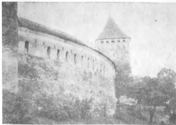
Turn şi porţiune de incintă (la Hărman, jud. Braşov) guri de păcură rezolvate în grosimea zidului.
