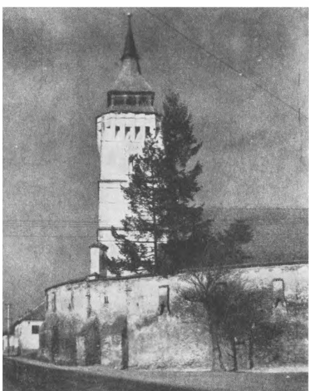
Zidul de incintă la Rotbav, jud. Braşov — burdufuri pentru păcură ieşite în consolă.
