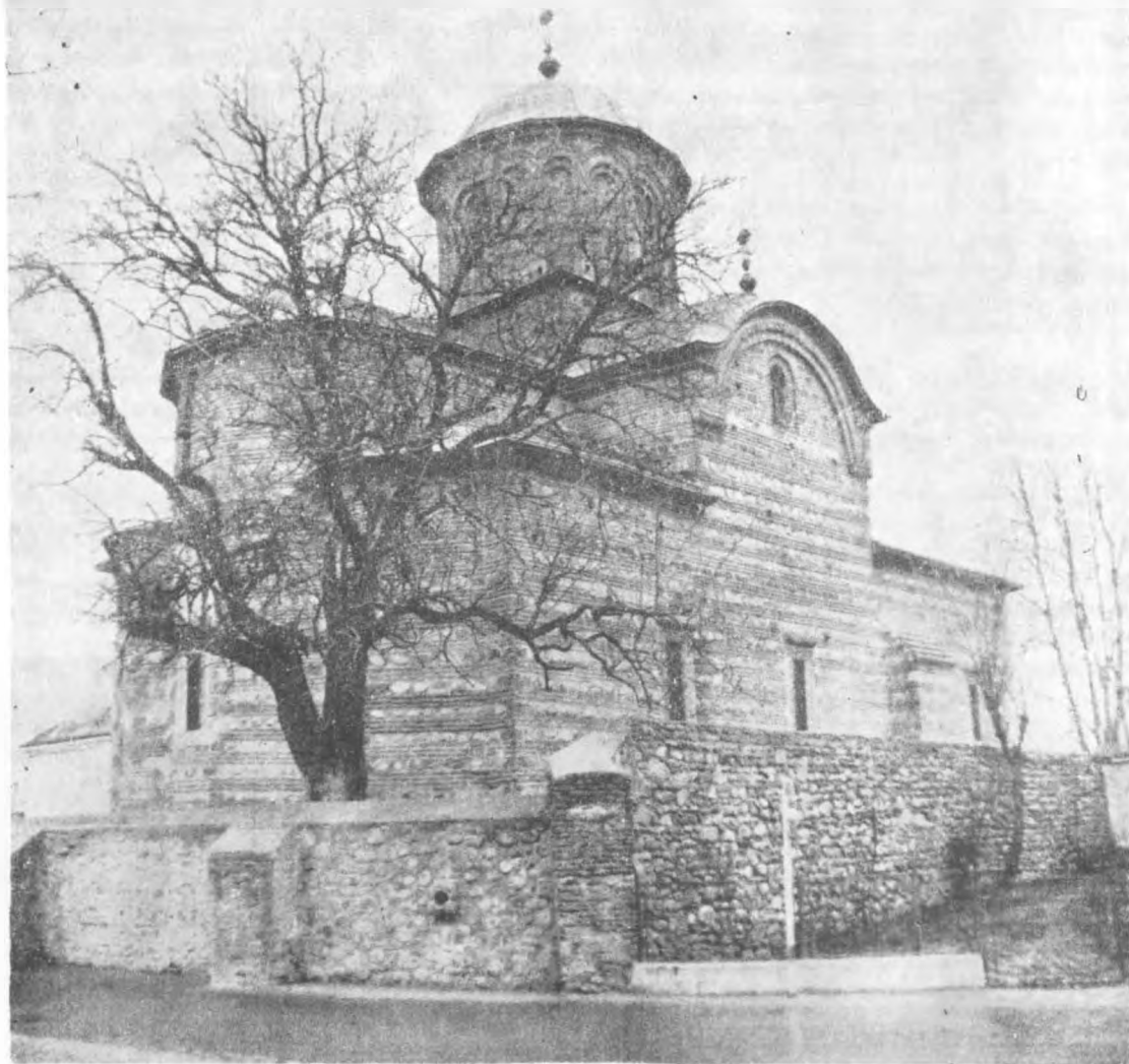
Biserica Domnească din Curtea de Argeș, monument la care ni se semnalează unele degradări pricinuite de cutremurul din 1838.
