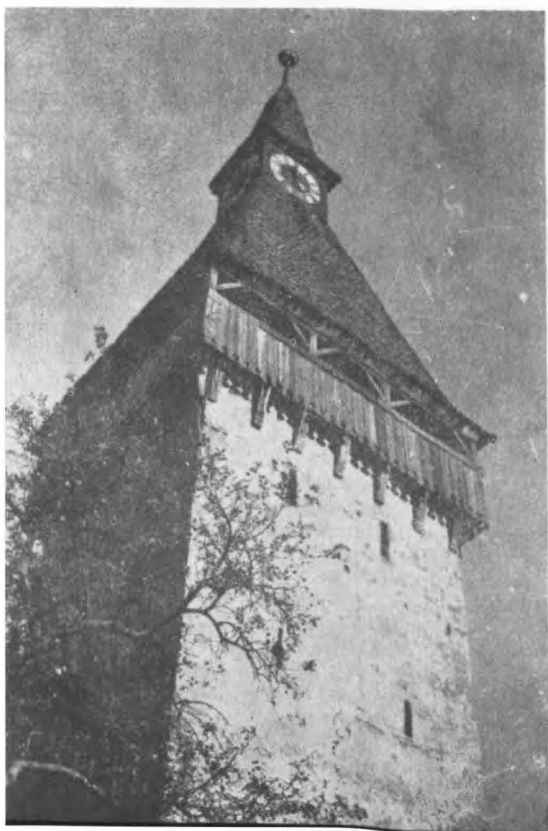
Turnul cu ceas al bisericii-cetate Biertan — detaliu, galerie de apărare cu parapet de lemn.
