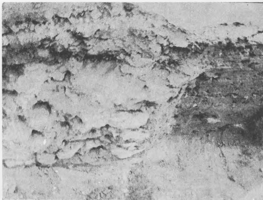
Hîrșova, 1988. Fundația zidu'ui de incintă în șanțul pentru conductă săpat în lungul str. Carsium
