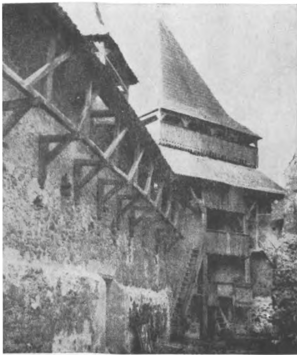
Drum de strajă pe console de lemn la biserica-cetate Homorod, jud. Braşov.
