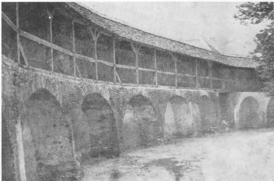
Incinta bisericii Valea Viilor, jud. Sibiu — drum de strajă pe arcade de zidărie.
