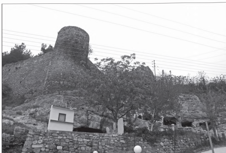
Abbildung 4a: In den Festungsfels geschlagene Wohnhöhlen am Fuße der Festung Didymoteichon (SO-seitig); Darüber im Hintergrund die Festungsmauern und der „Prinzessinenturm“ ( Pyrgos tis Vasilopoulas ). Davor eine (noch/wieder aktive) Tekke, die an die Bektasî-Tradition der Stadt erinnert. In einer ähnlichen Art von Unterkunft innerhalb der Festung soll Karl XII. als „Gefangener“/als „Gast“ İsmail Effendis (vgl. Abb. 4) gehaust haben. Foto U. Tischler-Hofer, Sept. 2011.
