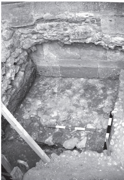
14. Fundația laturii de nord a corului gotic, văzută din exterior, în apropierea sacristiei. / The northern side foundation of the Gothic choir as seen from outside nearby the sacristy.
