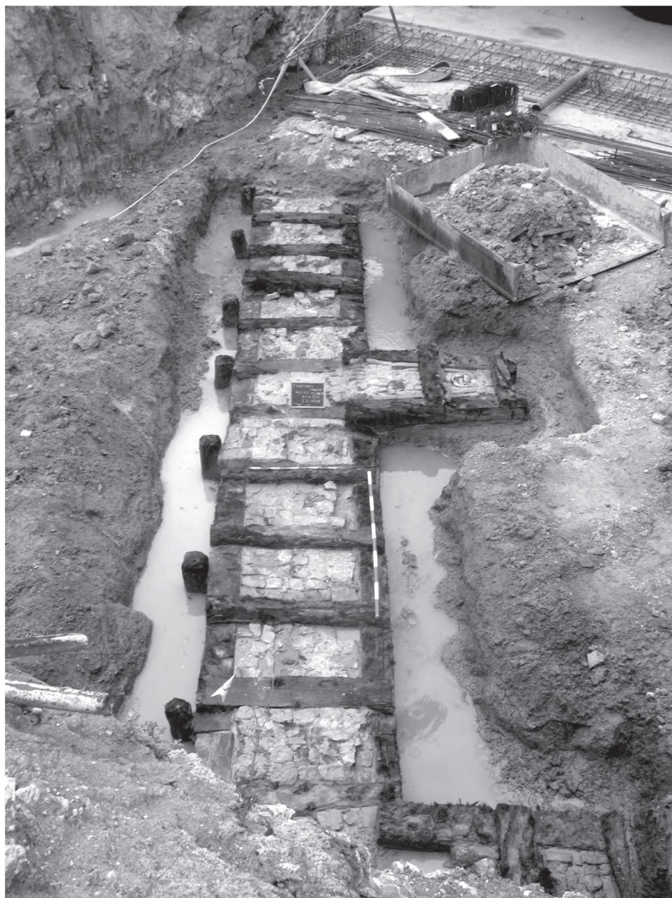
Pl. VIII. Substructura de lemn a zidului de escarpă a contragardei I. / The wooden substructure of the scarp wall of counter guard I.
