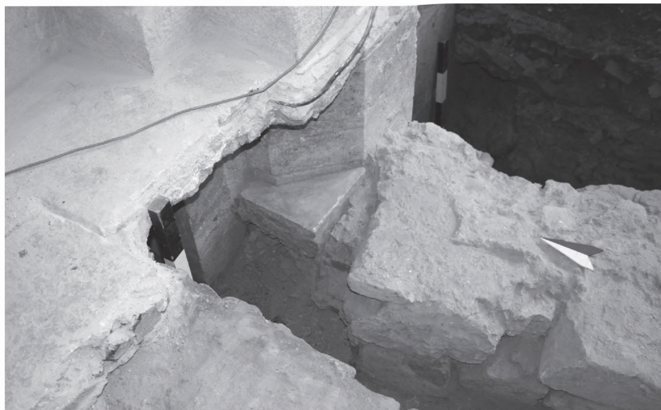
21. Detaliu cu zidăria gotică la decroșul nordic al sanctuarului. În apropierea pilastrului, un fragment din pardoseala gotică din lespezi de piatră. / Detail of Gothic wall in the sanctuary northern falling out point. A fragment of the Gothic stone floor, nearby the pilaster.
