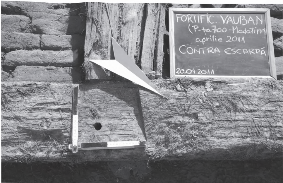
Pl. III. 1. Sistemul de îmbinare a lonjeroanelor contraescarpei; 2. Decupajul pentru fixarea uneia dintre antretoazele contraescarpei. / 1. The system of the counterscarp longitudinal beams joining; 2. Cutting out for fixing one of the counterscarp sleepers.
