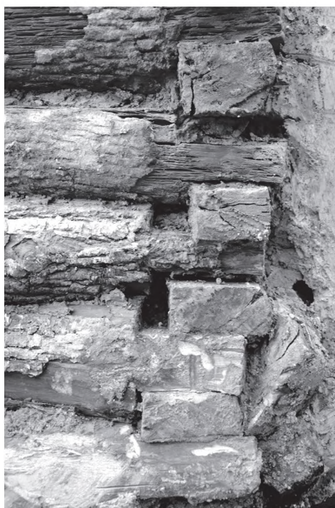
Pl. X. 1. Fântâna din lemn aparținând perioadei otomane; 2. Detaliu cu sistemul de îmbinare a pereților din lemn. / 1. The wooden well belonging to the Ottoman time; 2. Detail on the wooden walls joining.
