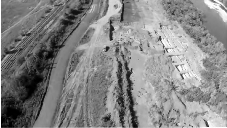
Foto 19. Sistemul de fortificare zona C – detaliu de lucru, septembrie 2011. / The defense works system C – detail, September 2011.
