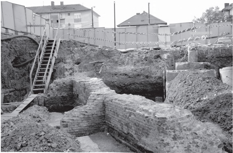
Pl. VII. 1. Detaliu cu îmbinarea antretoazei cu lonjeroanele contraescarpei; 2. Fundația de cărămidă a zidului de escarpă a contragardei I. / 1. Detail on the counterscarp longitudinal beams and sleepers joining; 2. The brick foundation of the scarp wall of counterguard I.
